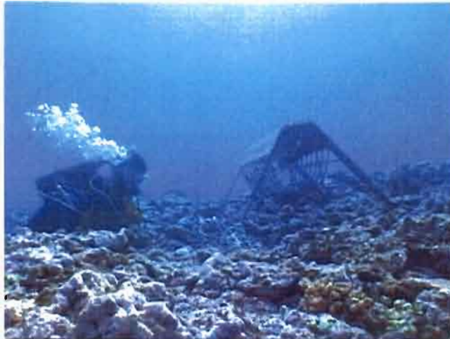
Installation du support du marégraphe du Banc Sabine en nov. 1999
