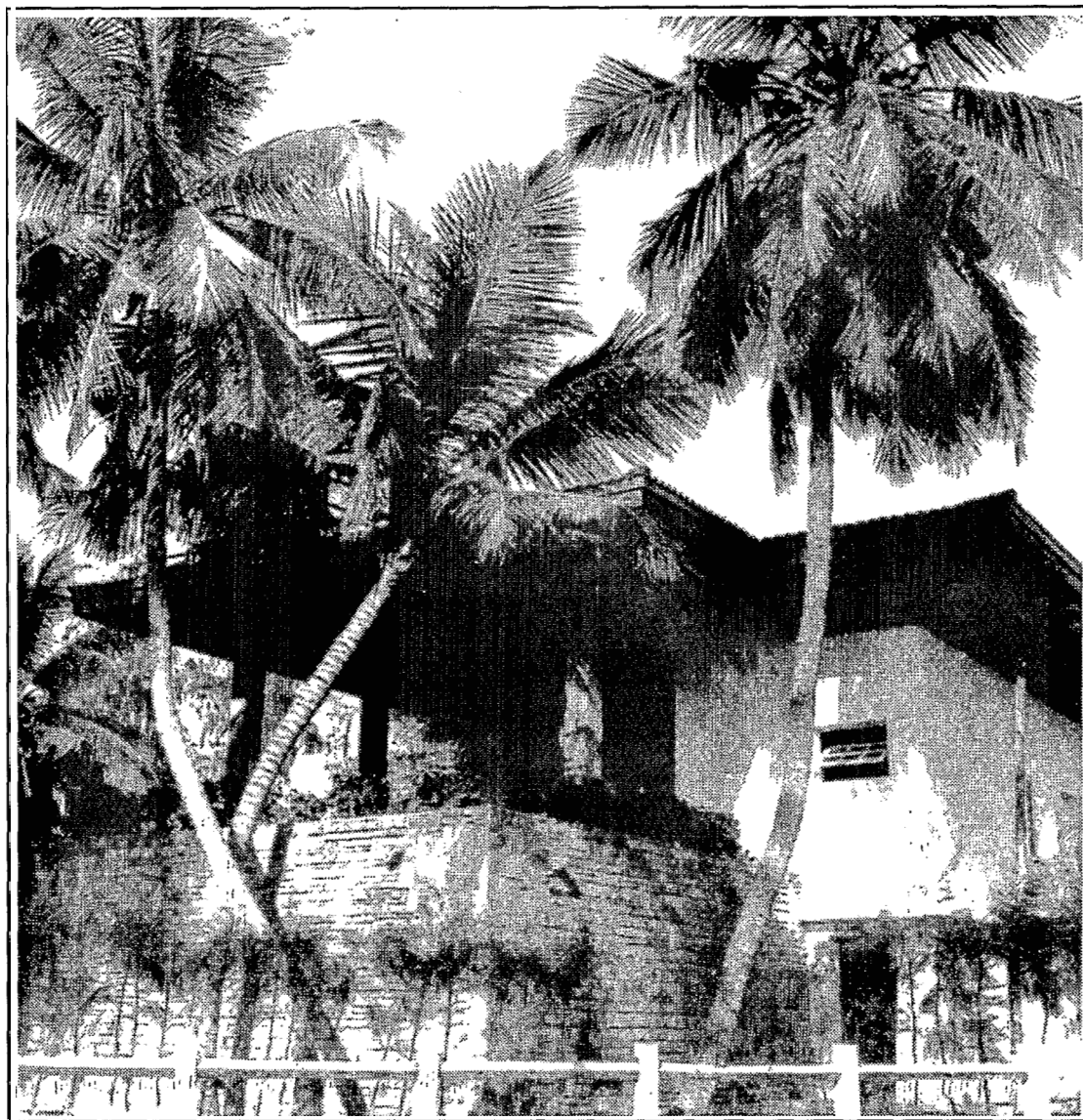
155) Au sud-est, une véranda largement ouverte sur la brise du large. Cliché collection Coustère.
