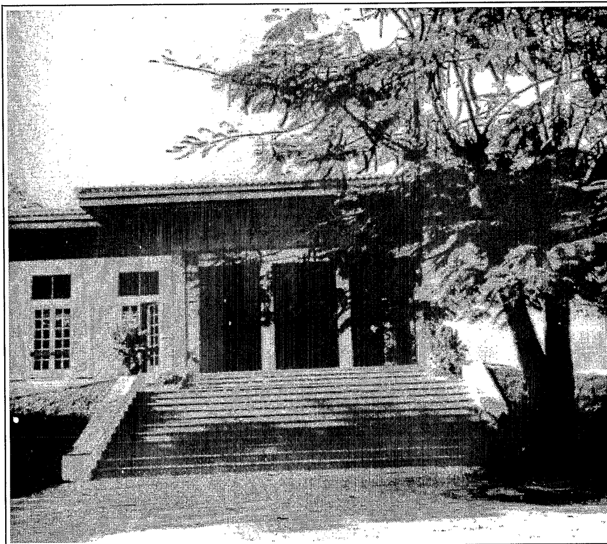
153) Dernière réalisation de Georges Coustère au Togo, en 1968, et sans aucun doute l'un de ses chefs-d'oeuvre : la résidence de l'ambassadeur de France. L'entrée, à la fois monumentale et accueillante.
