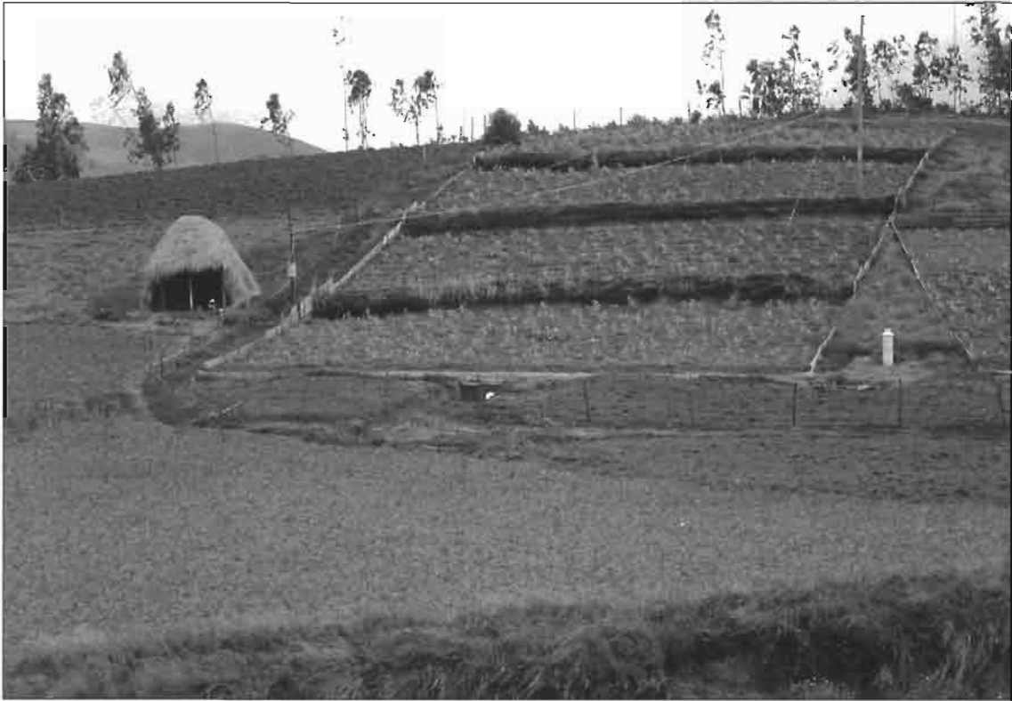
Station de mesure de l'érosion de Riobamba, à 3 250 m d'altitude. La photo est centrée sur la grande parcelle expérimentale de ruissellement qui porte des bandes enherbées isohypses ; sur le côté droit apparaît partiellement l'une des petites parcelles expérimentales. La pente générale de la station est de 35 %. Les projections volcaniques sont importantes car le volcan Chimborazo est tout proche ; les sols qui en dérivent sont des andosols vitriques.
