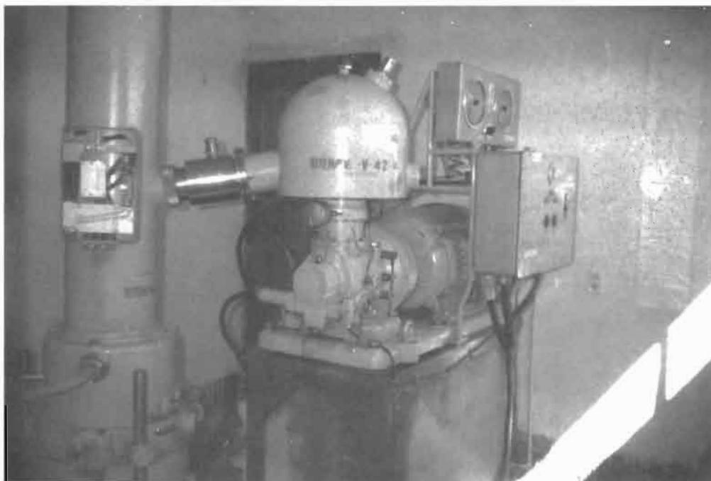
FOTO N° 4 . Generador de nitrógeno líquido
