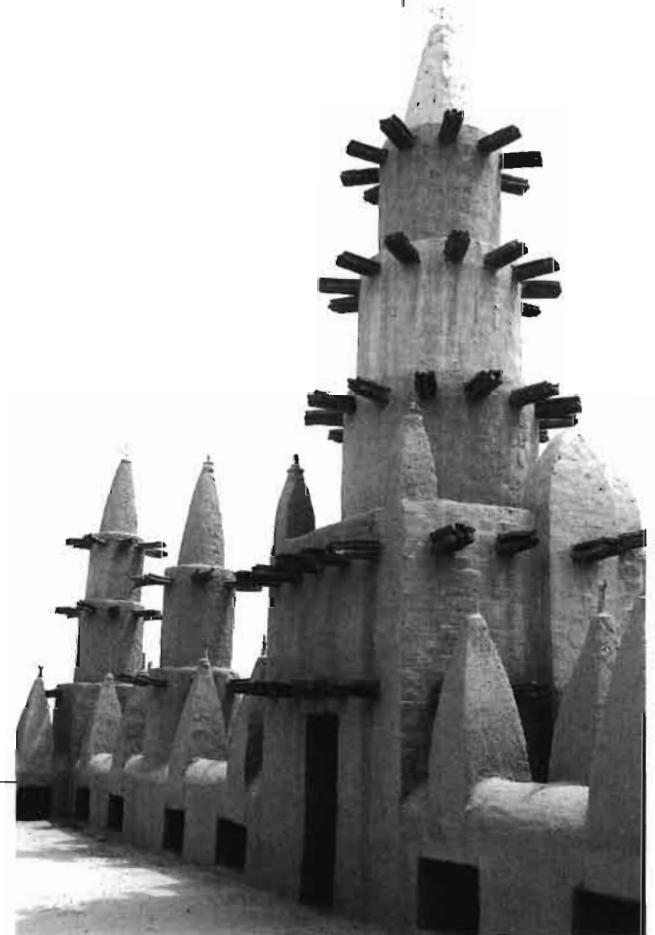
Mosquée de Kootaka (partie supérieure) de type soudanien, hérissée de piquets de bois qui permettent sa réfection.
