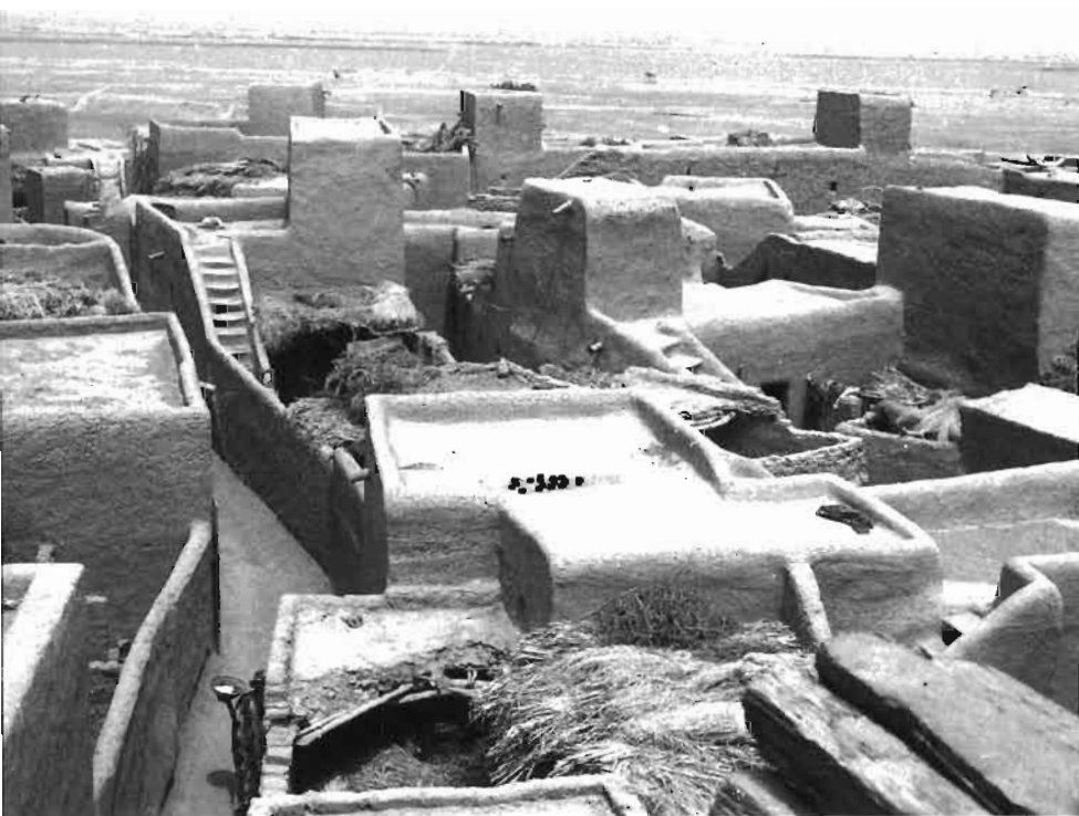
Le village de Kootaka, est habité par une population composée de Marka et de Bozo. Il est construit de cases de banco sur les toits desquelles on accède par un escalier situé dans la concession.
