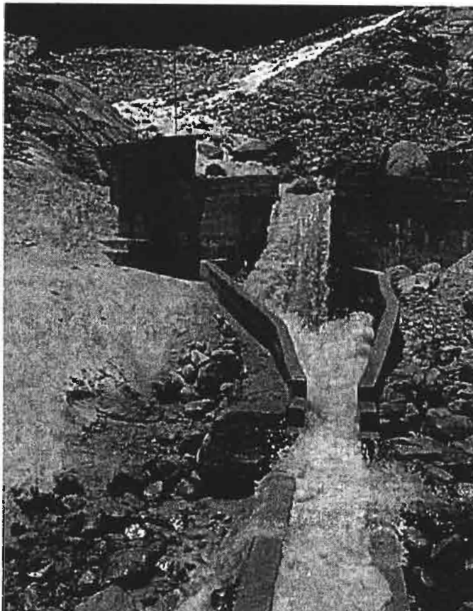
Photo B.1 : Station limnigraphique à 4830 m (Berthier 2000).
