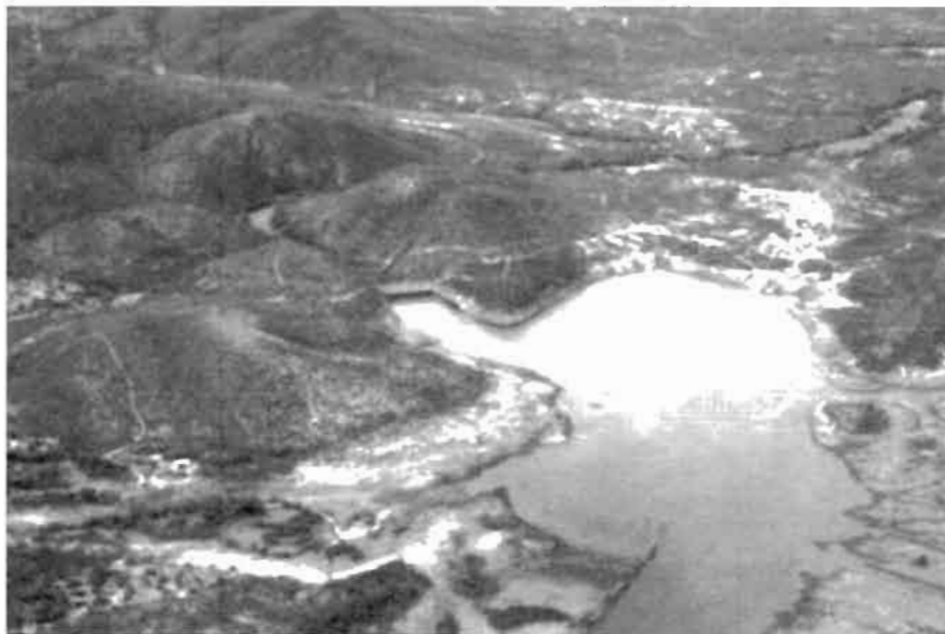
Figura 0.7. Presa en el río Matapé (estado de Sonora).
