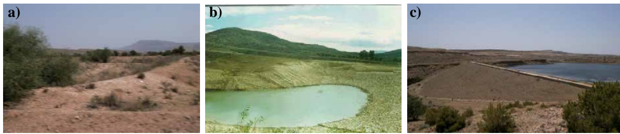
Figure 3. Exemples d'aménagements. a) banquettes. b) retenue collinaire. c) barrage collinaire.
