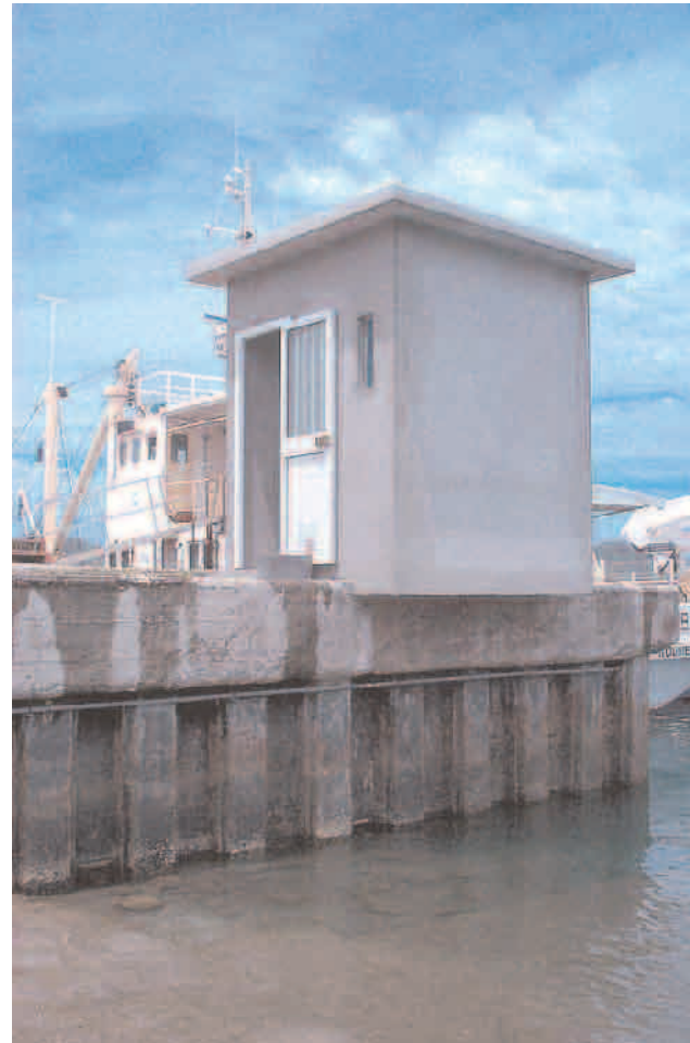
Figure 23 : Local technique abritant le marégraphe.
