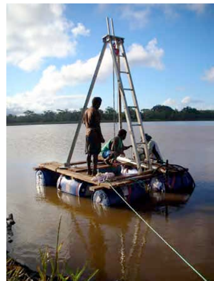
montage du carottier pour OTAI
