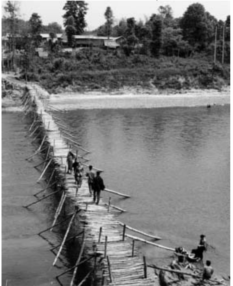
Pont provisoire entre les deux rives de la Nam Tha, près du centre administratif du district de Nalae.
