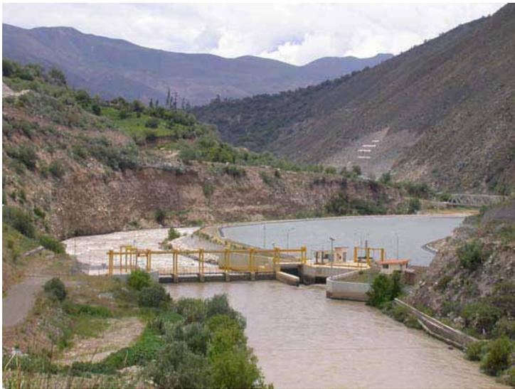
**Figure 2. 1 : Réservoir San Diego, placé au flanc gauche du río Santa avec une capacité maximale de 725 583 m<sup>3</sup>. Il est utilisé pour réguler le débit journalier de la central hydroélectrique « El Pato ».**
