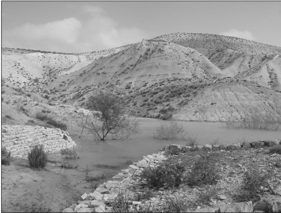
**Figure 4.** Sédimentation d'un petit lac collinaire causée principalement par le ravinement d'un glacis encroûté sur marnes situé en amont (El Hnach, juillet 2001, cliché E. Temple-Boyer).
