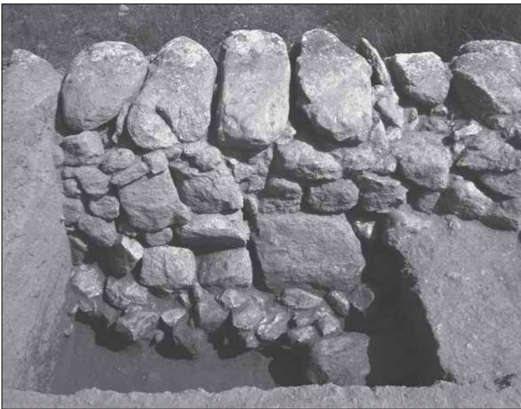
■ Photo 3 Parement extérieur d'une terrasse.
