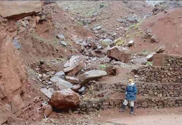
Dégâts d'une crue décennale sur un seuil : noter la taille des blocs transportés dans le ravin lors des crues (Azaden, Haut Atlas).
