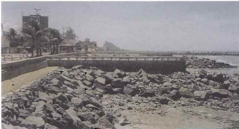
Figura 4 – Orla de Olinda, Avenida Senador Marcos Freire, onde se podem notar as obras de contenção do avanço do mar onde outrora existiam os bares que foram transferidos para o lado esquerdo da avenida.
