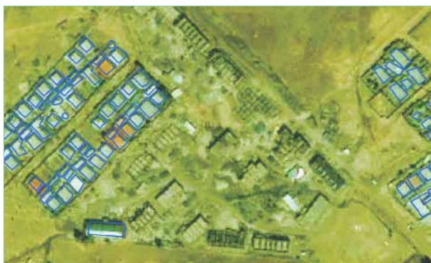
— Tracé des bâtiments présents sur la première image Ikonos du 14-11-2007 et donc présents sur la cartographie réalisée. Nous n'avons pas alors tracé les constructions en cours, une seule ayant été pourvue d'un toit
