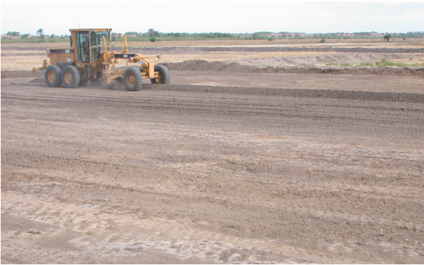
Fig. 15. Réhabilitation de périmètre
