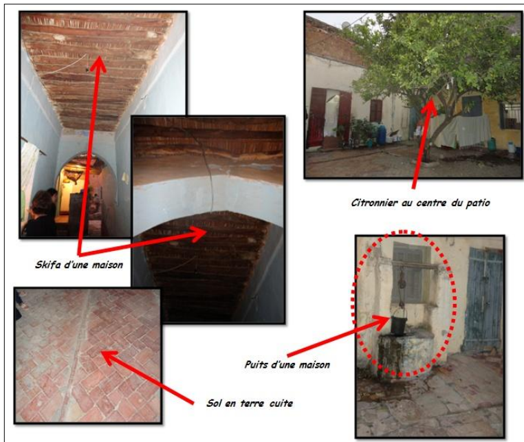
Figure 12. Quelques éléments architectoniques caractérisant la ville de Tlemcen
