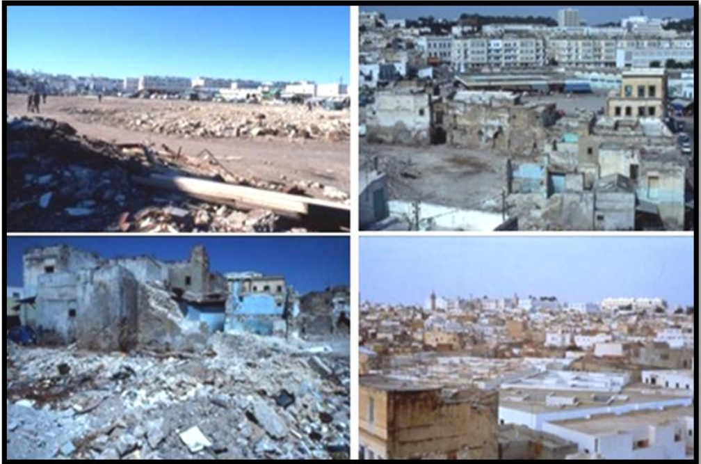
Figure 15. Le quartier HAFSSIA avant sa réhabilitation
