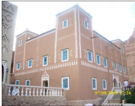
Photo 5. Une maison traditionnelle construite en pisé transformée en hôtel
