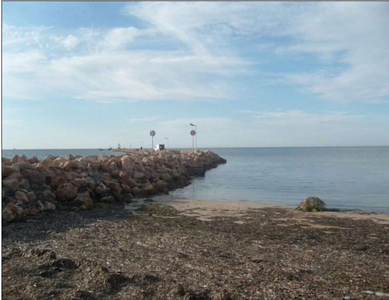
Photo 2. La partie engraisée par la dérive littorale au Nord de la digue de Sidi Fraj
