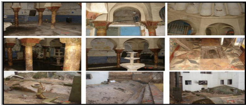
Figure 25. Les travaux de restaurations de Hammam Essebaghine (XII e siècle)
