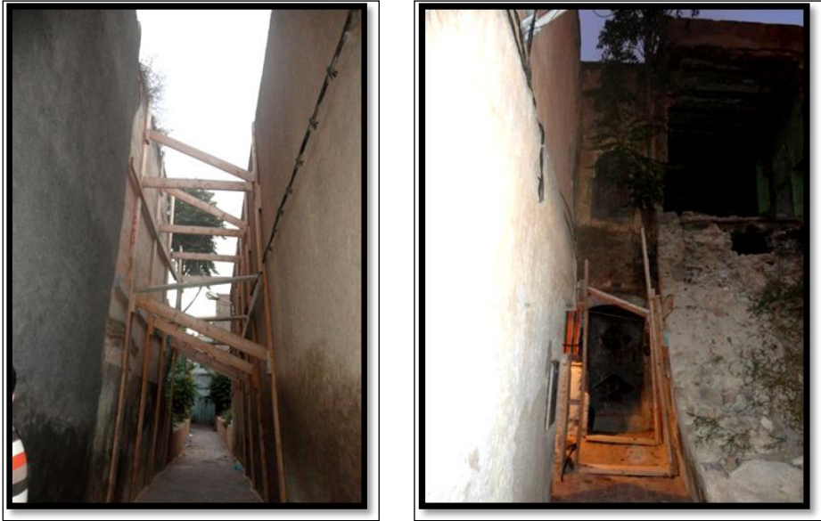
Figure 26. Les consolidations des maisons du quartier R'hiba
