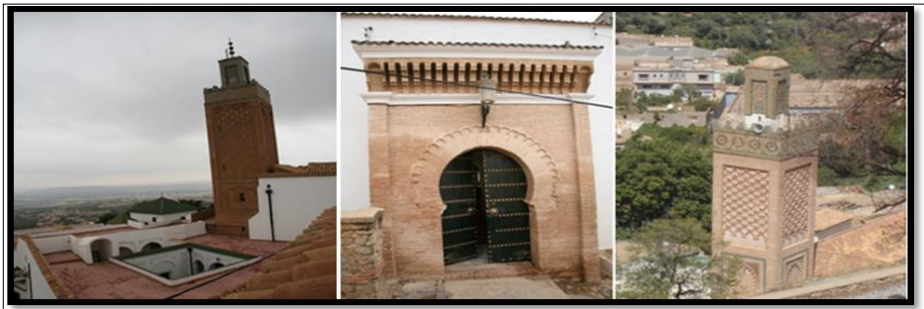
Figure 9. La mosquée Sidi Halloui
