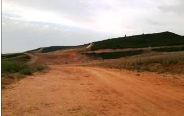
Défrichage de l'assiette de l'autoroute Est-Ouest.
