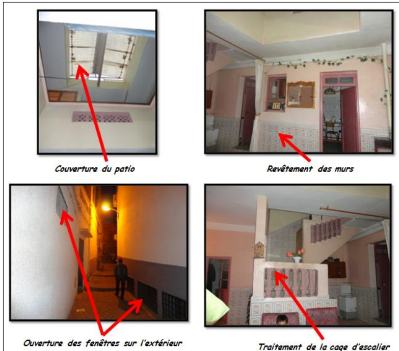
Figure 29. Les modifications effectuées sur les maisons traditionnelles
