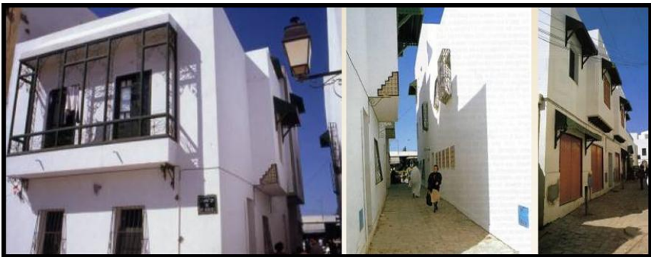
Figure 16. Le quartier Hafssia après sa réhabilitation
