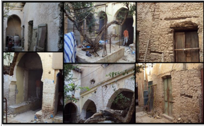
Figure 23. La restauration du fondouk Roumana
