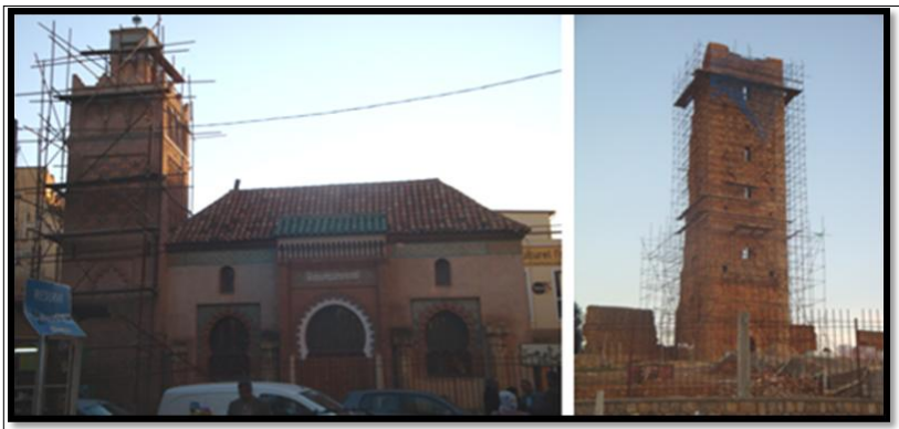
Figure 22. La restauration de la mosquée de Sidi Belahcen
