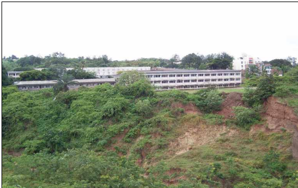
Photo 8 : Bâtiments menacés d'effondrement – Lycée Clarté N.D. de Bujumbura
