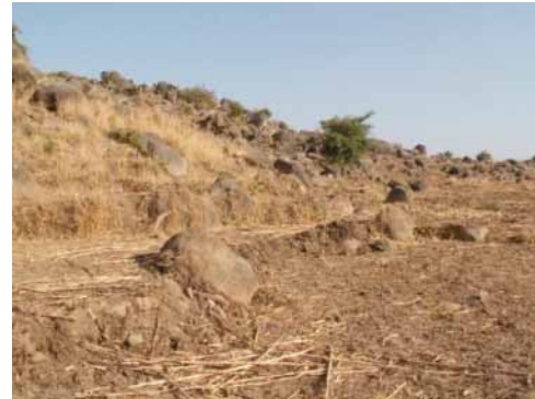
Photo 6. Karanchi, 24 – I – 2007 Terrasses construites dans des altérites, arrimées à de gros blocs rocheux ennoyés par des colluvions
