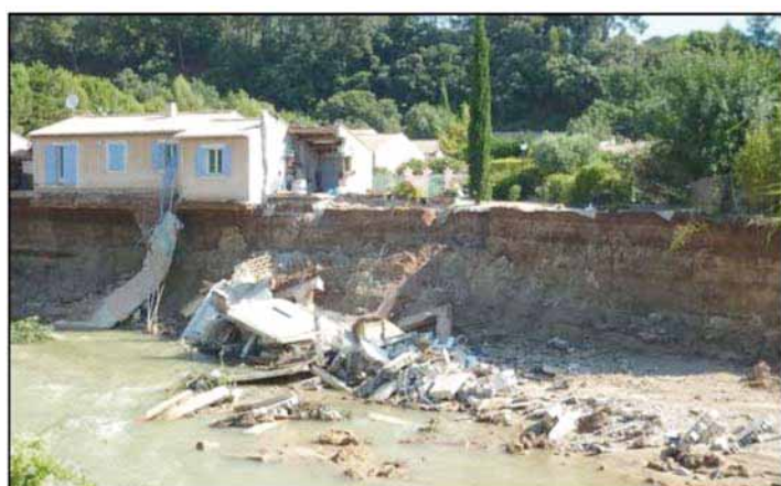
Photo 5 : La Motte - Sapement de berge et effondrement de villas au niveau du lotissement "Les Hauts de la Nartuby". [Cliché : Les Agités de La Motte – Site : http://lesagitesdelamotte.unblog.fr/ ]
