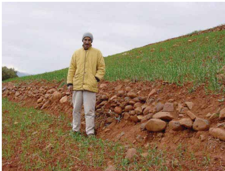
Photographie 5 : Murette non entretenue installée par un ancien projet
