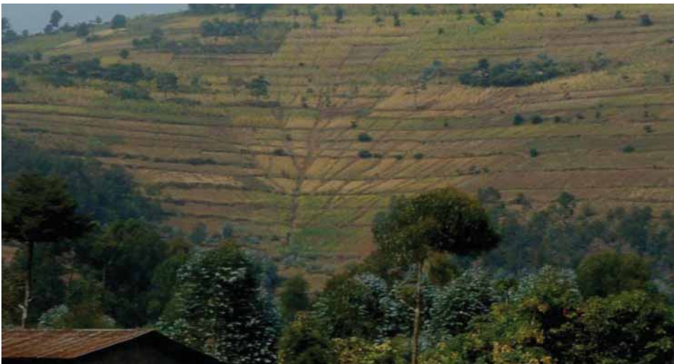
Photo 02 : Erosion sur terrains très pentus surexploités.
