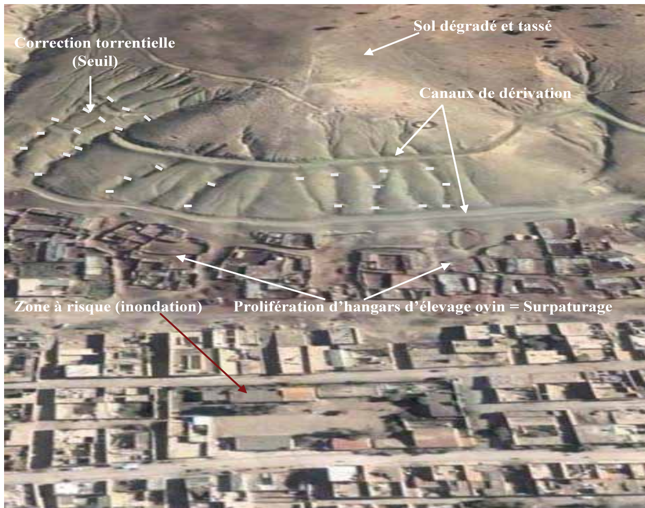
Photo n°1. Une portion de versant marneux dénudé et tassé par le surpâturage, provoque l'inondation de l'agglomération par les torrents. Dispositifs de lutte anti-inondation : correction torrentielle et canaux de dérivation.
