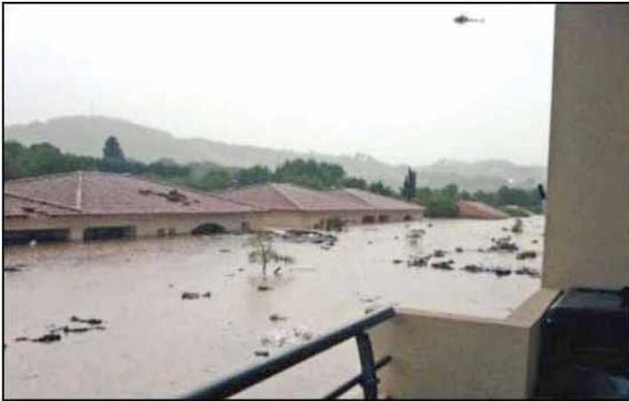
Photo 3 : Draguignan - Le lotissement "Les Florentins", dans la partie ouest de la ville.
