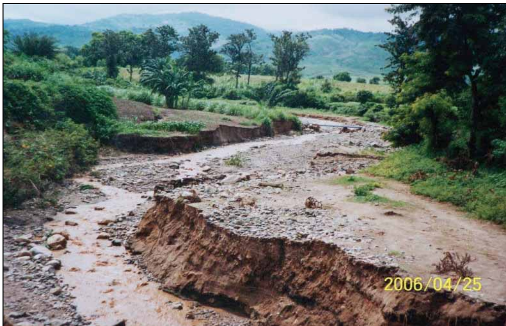
Photo 10 : Erosion du lit de la rivière Muha lors d'une pluie exceptionnelle
