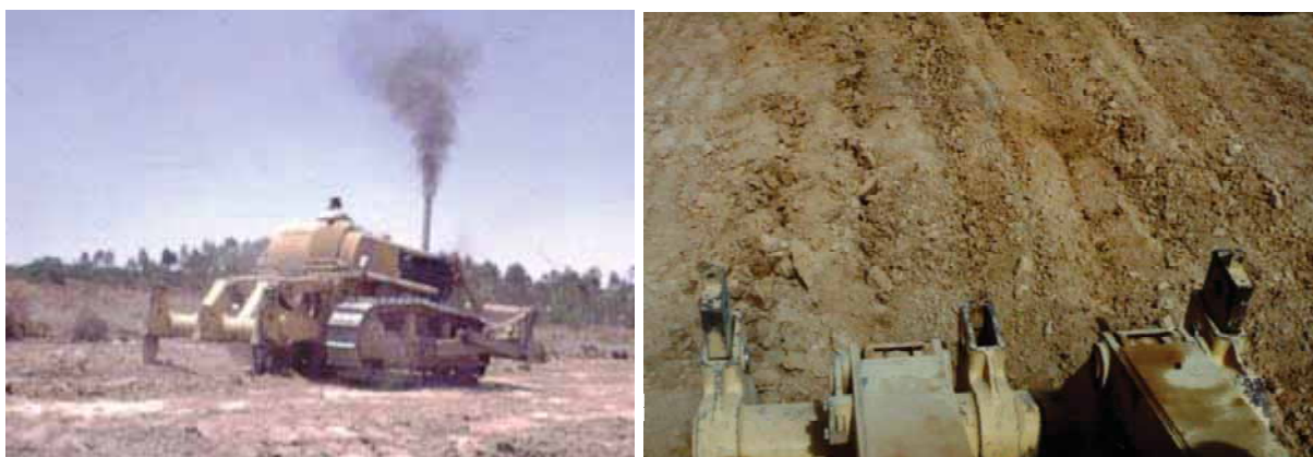
Photos 4a et 4b. Défonçage au bulldozer muni de 3 dents du tepetate , S.M. Tlaixpán, Mexique (Prat).
