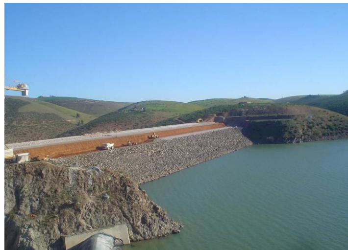
Fig.3 : Photo des travaux de surélévation du barrage SMBA (2006), source : ABHBC (Rabat, Maroc)
