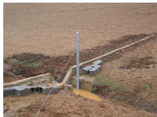
Photo 3 : Le déversoir en V
