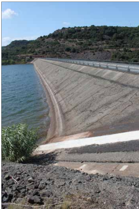
(a) Retenue du barrage du Salagou côté amont, juillet 2011.
