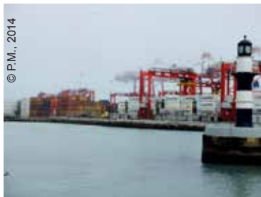
Le port et l'aéroport : deux grands équipements structurants
