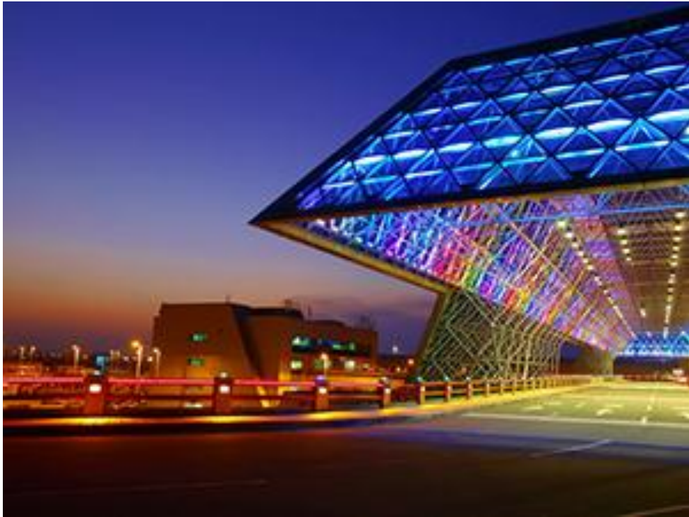
Figura 11. Iluminación LED en Edificios Gubernamentales.
