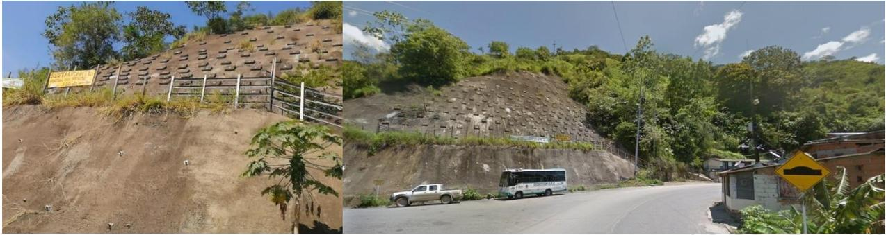
Fotografía 10. Estabilización de talud en la entrada del corregimiento de Puerto Valdivia.
