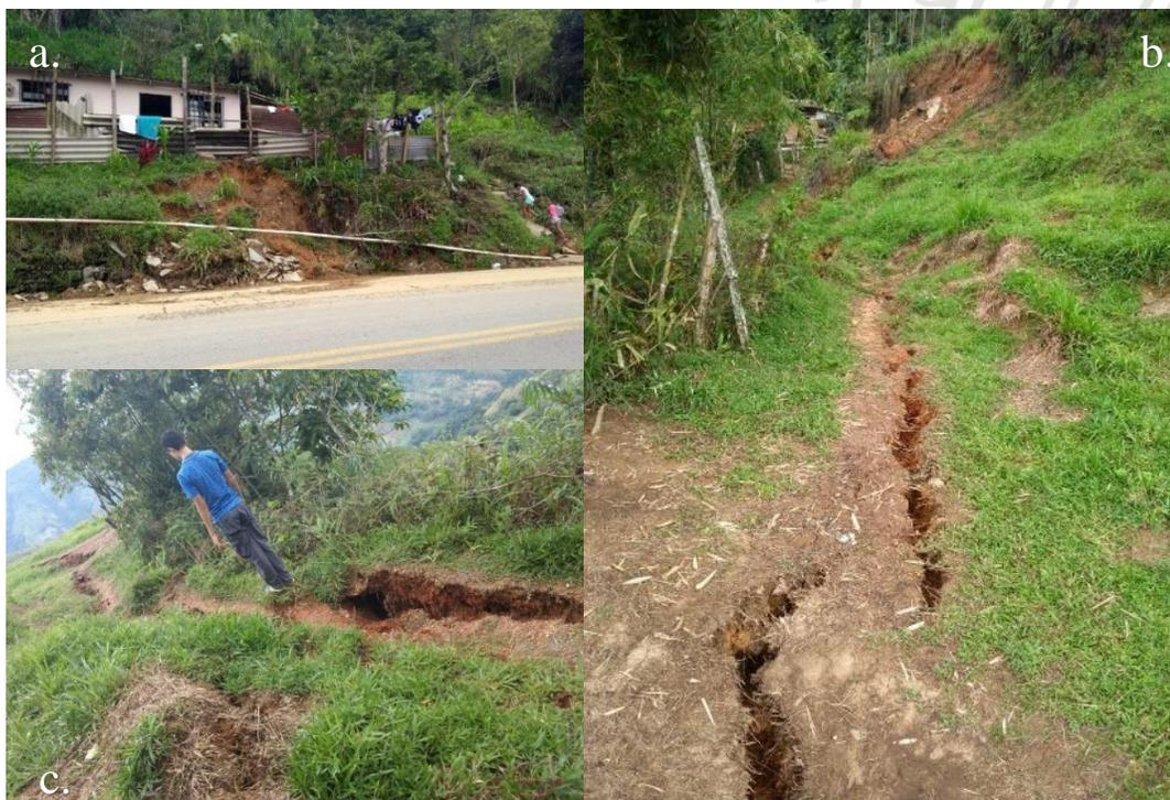
*Fotografía 8. Grietas en superficies activas de falla en los Barrios Templete y Palmarito- sector Sevilla, el 30 de mayo de 2018. Fotografías Secretaría de Planeación de Valdivia; a. Viviendas sobre la faja de la Troncal de Occidente (Km 62 +000); b. Grietas de tracción que avanzan sobre el talud; c. Habitante del barrio caminando con descuido sobre la grieta.*
