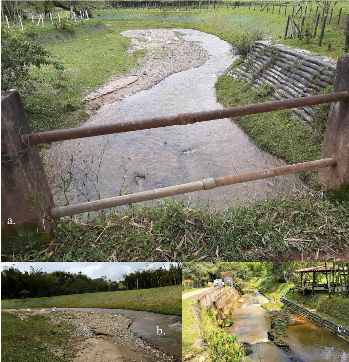
*Fotografía 12. Canalización de la quebrada La Cueva; a, b. Intervenciones de las márgenes con geomembranas e hidrosiembra de pastos, método que facilita la infiltración; c. Muros en gaviones, costales de fique y suelo cemento en las márgenes de la quebrada La Cueva, vereda Chiquinquirá.*
