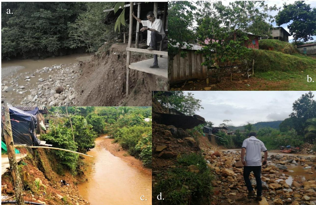
*Fotografía 6. Viviendas informales sobre la corona de un talud, en el borde de la quebrada Probá – Vereda El Santillo, algunas colapsadas parcialmente. Municipio de Zaragoza*
