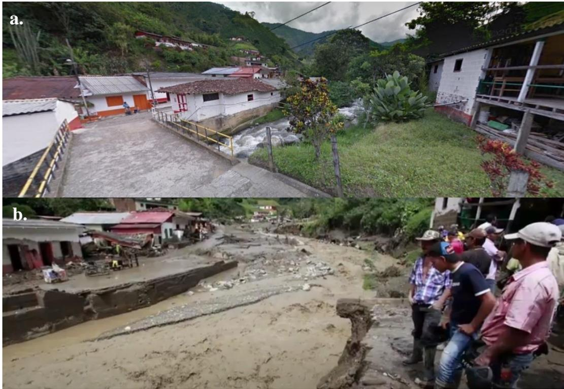
Fotografía 14. Antes y después de la avenida torrencial en el corregimiento La Margarita; a. Puente de pavimento rígido usado por los pobladores (Antes) y b. Puente colapsado y arrastrado desde sus estribos sin dejar rastro (Después) coordenadas  $5^{\circ}57'30.58''$  N,  $76^{\circ}00'23.15''$  O. Foto captura Google Maps (2014) y diario El Colombiano
