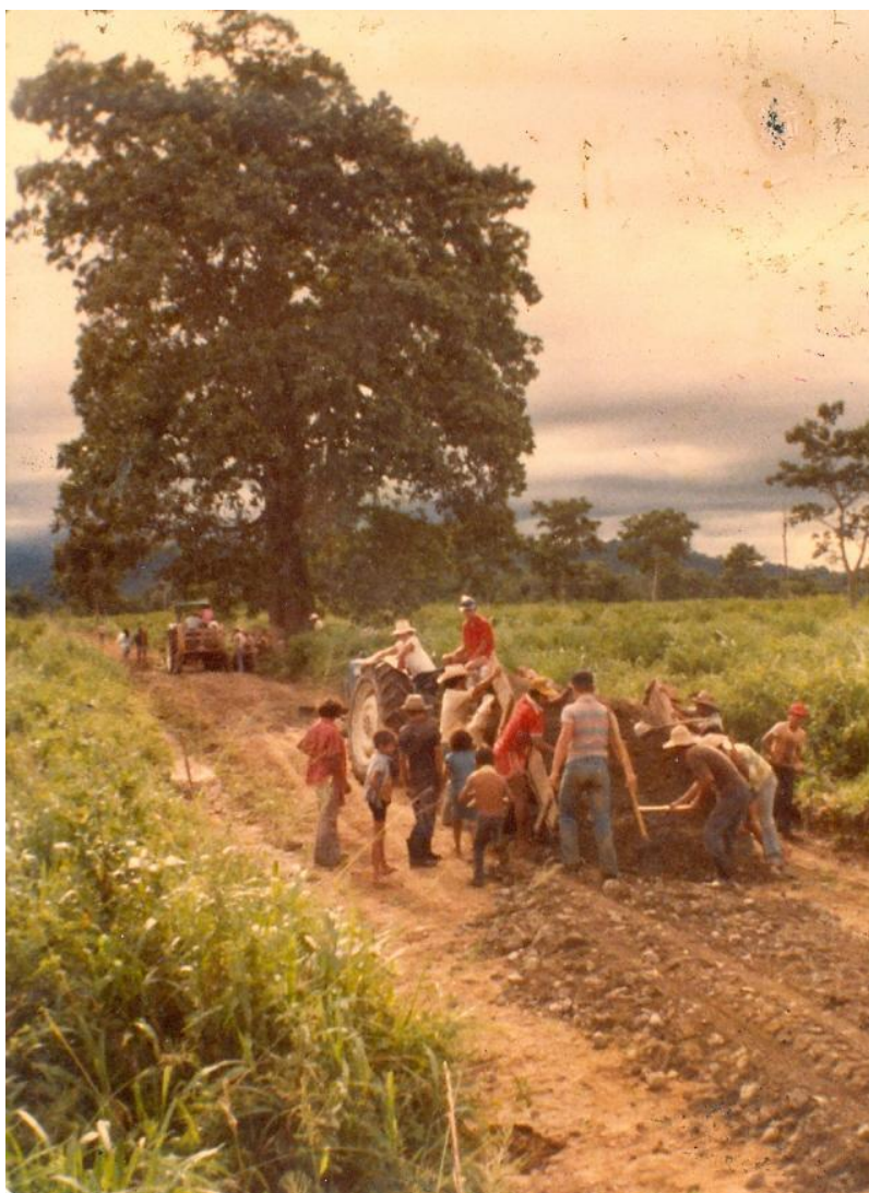
Imagen 14. Construcción de la carretera Gilgal-Santa María. Archivo fotográfico Cooperativa Las Tribus.
