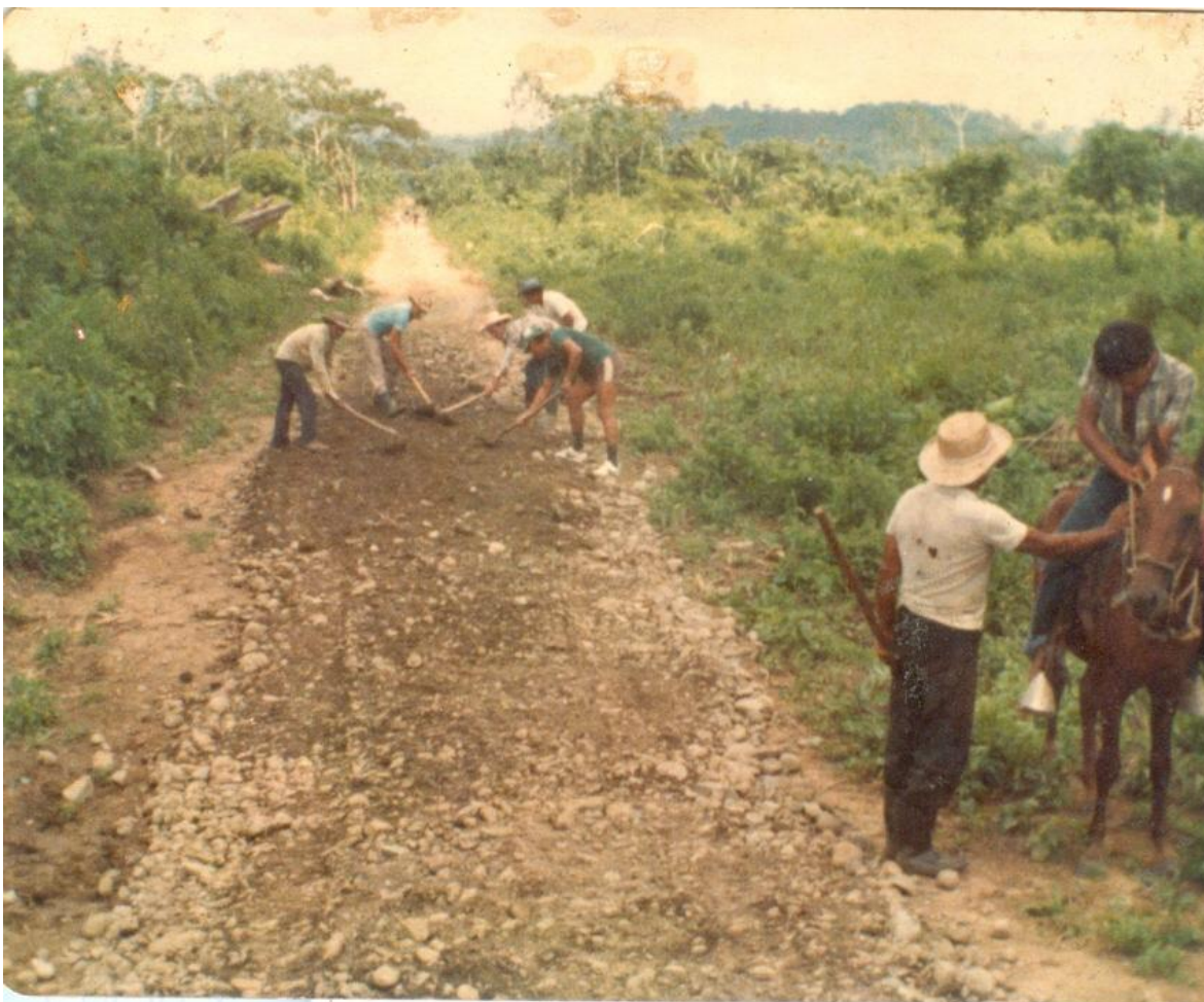
Imagen 15. Relleno con balastro de la carretera Gilgal - Santa María. Archivo fotográfico Cooperativa Las Tribus.
