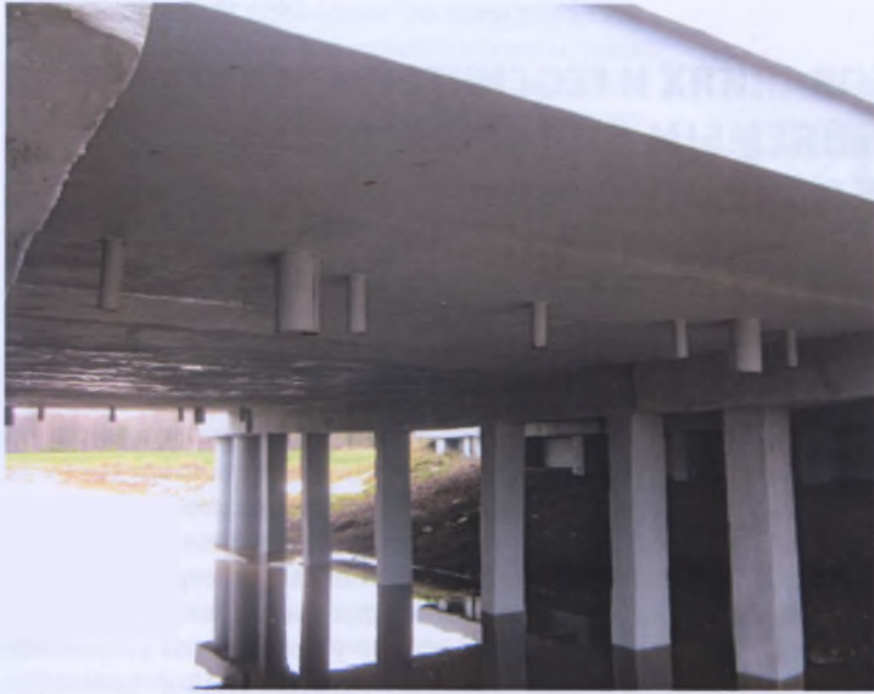
Рисунок 4 – Вид пролетного строения после ремонта моста через канал на км 160,524 автомобильной дороги Р-23 Минск – Микашевичи
