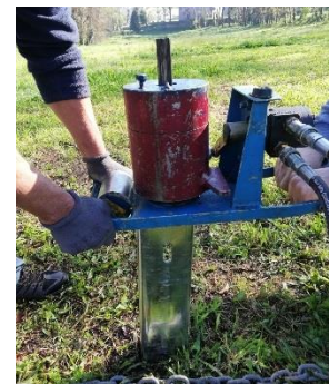
(c) Cravação do prumo com uso a meio mecânico
