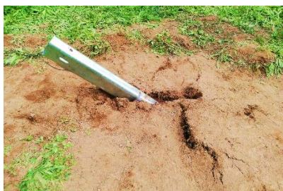
(c) Vista lateral de fendilhação do solo circundante P2
