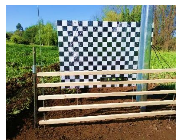
(c) Fase de montagem dos equipamentos de ensaios estáticos
