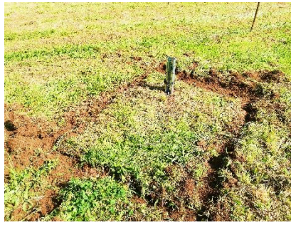
(a) Marcação de limites da área de intervenção com 2,50 x 1,50 m 2 .
