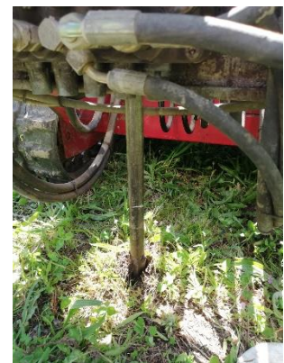
(i) Fase terciária de cravação da ponteira dilatométrica
