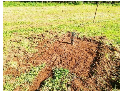
(b) Remoção da camada superficial da área de ensaio.
