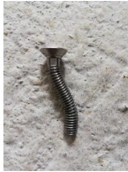
(a) Parafuso com deformações por corte após cravação do prumo metálico.
