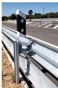
(a) Ligação prumo – viga “W” de segurança
