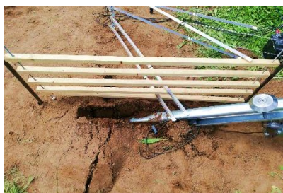
(a) Hastes horizontais superiores perdidas P2
