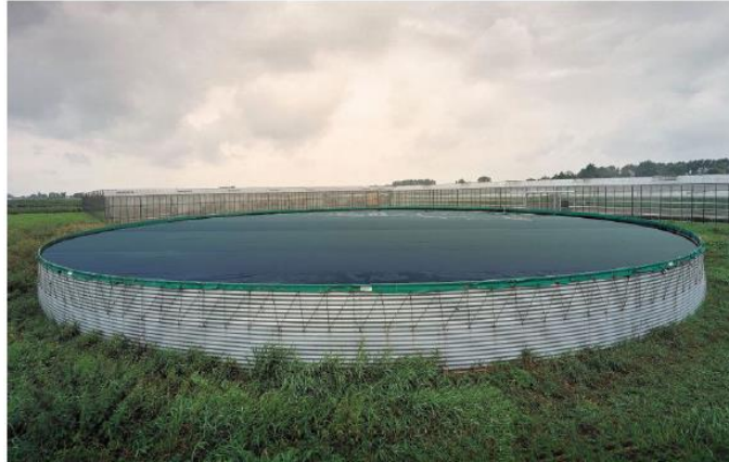
Figura 30 Reservorio en Acero Galvanizado para riego. Tomado de: (Santos, 2015)
