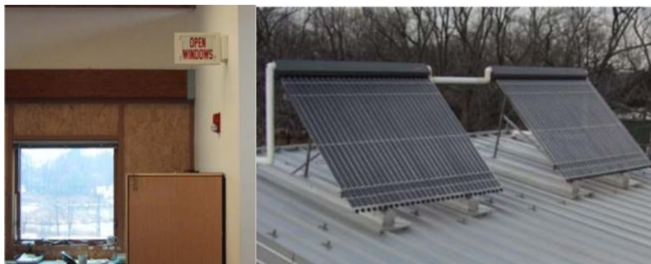
Figura 9 Izq. Sistema de aviso apertura de ventanas. Der. Paneles Solares Térmicos. Tomado de:(Griffith et al., 2005)
