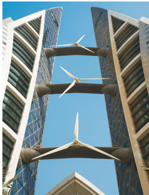
Figura 19 Aerogeneradores edificio Bahrain World Trade Center. Tomado de de:(ciudadesdelfuturo, 2011)
