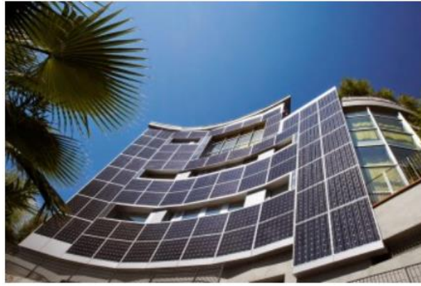
Figura 14 Edificio con Paneles solares fotovoltaicos en la fachada. Tomado de:(Energíasolar, 2018)
