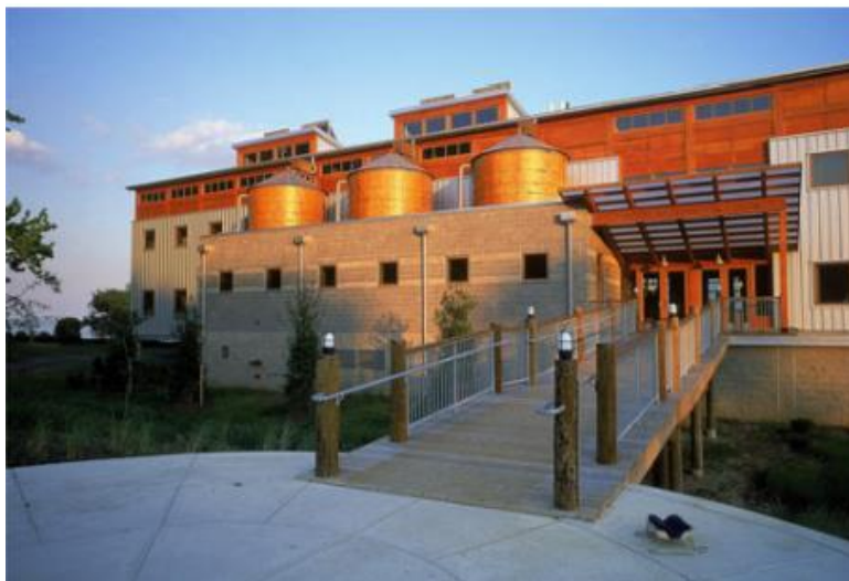
Figura 10 Fachada Norte, donde se evidencia los reservorios para las aguas pluviales. Tomado de:(Griffith et al., 2005)
