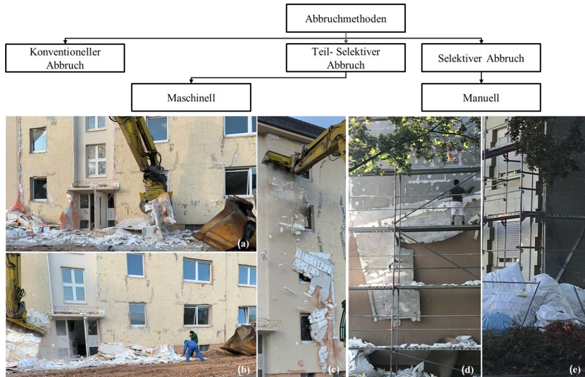
Abbildung 2-6 Stand der Technik: Methoden zum teil-selektiven (a-c) [33] sowie selektiven Abbruch (d,e) von WDVS
