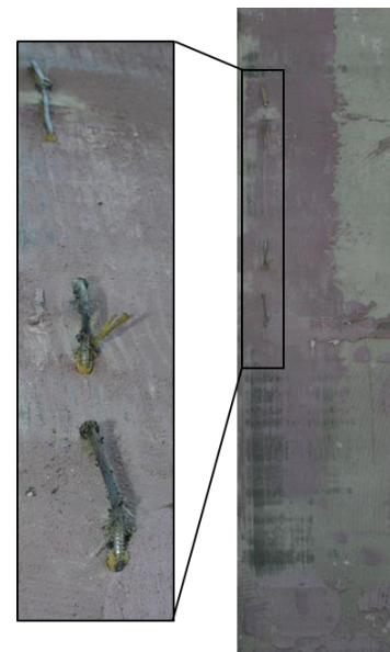
Abbildung 5-44 Aufnahmen der Verdübelung nach der Praxisanwendung des Baggeranbaugeräts
