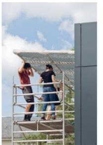
Studierende beim Anbringen von Elementen, mit denen der Einfluss eines Gitterrost-Laubengangs an der Fassade des LOBSTER untersucht wurde.
