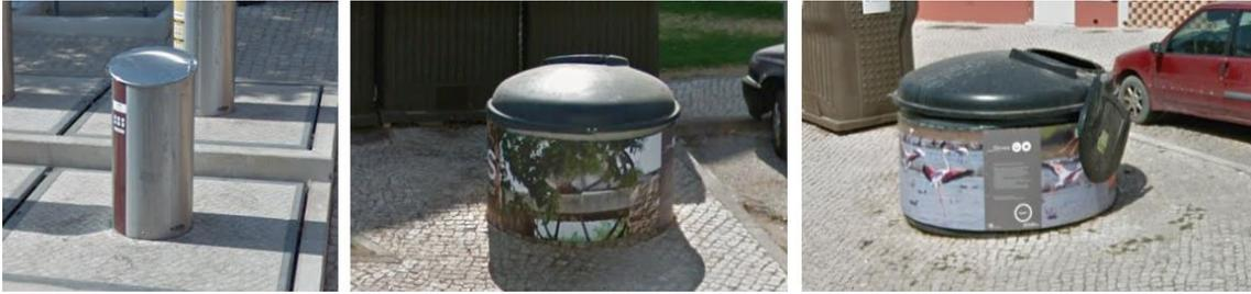
Figura 4.5 - Contentores enterrados: Sotkon de 3000 litros e Molok de 3000 e 5000 litros (Google, 2020)
