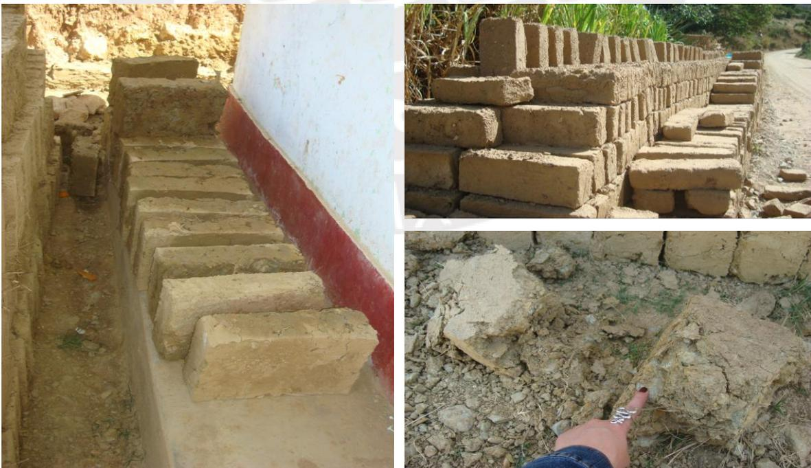
Fig. 1.5 Secado y almacenamiento de unidades de adobe a la intemperie (izq. y der. superior). Ruptura de unidades sin uso: poca cantidad de paja, granulometría irregular y uso de piedras mayores a  $\frac{1}{2}$ " (der. inferior).
