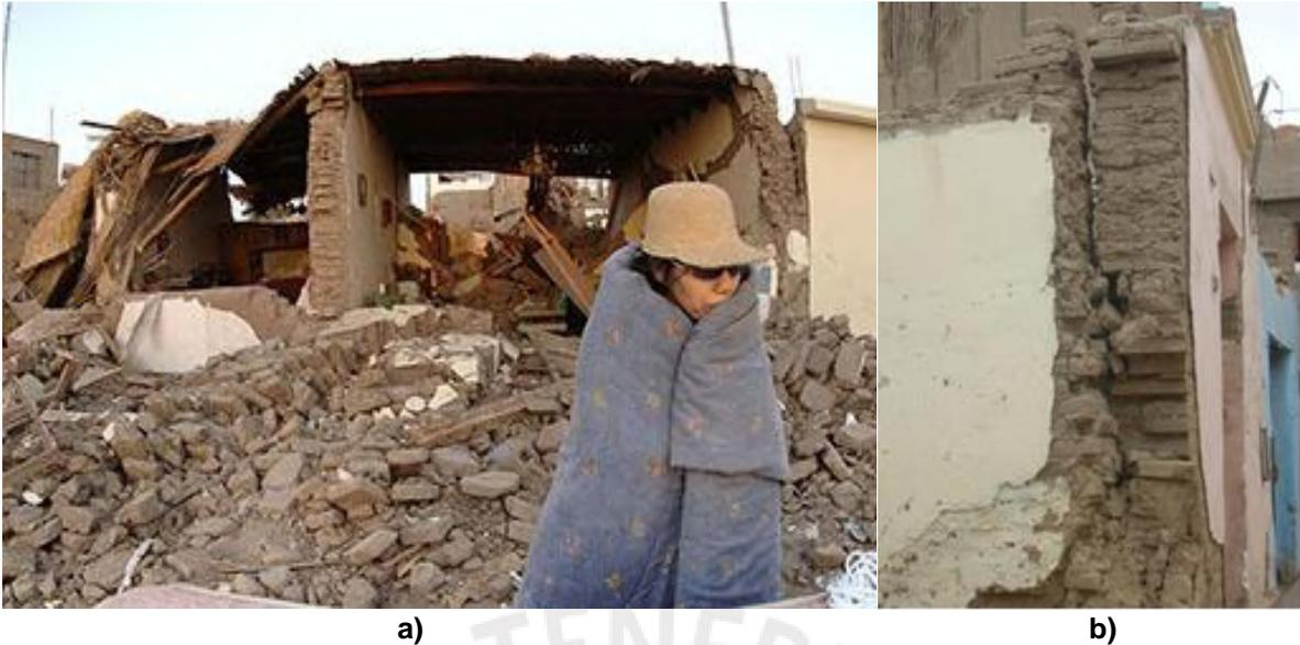
**Fig. 1.12 a) Colapso de muros por falta de elementos de confinamiento. [www.lineadetiempo.iep.org.pe](http://www.lineadetiempo.iep.org.pe). b) Encuentro de muros sin conexiones dentadas entre sí. Sismo en Pisco, Perú 2007 (Misión CERESIS/UNESCO).**
