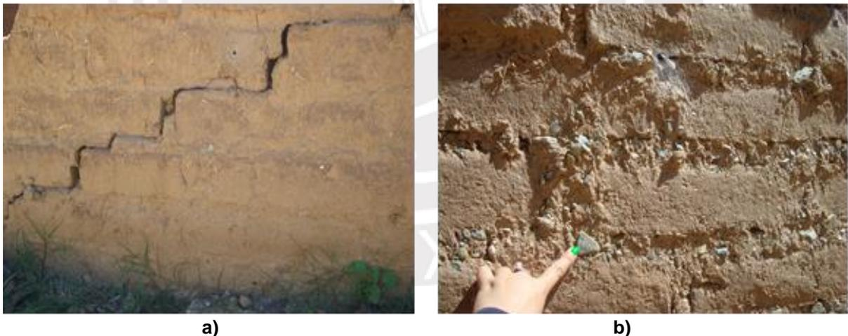
**Fig. 1.13 a) Falla de muro por fuerzas actuantes en su plano. b) Detalle de mortero con piedras demasiado grandes para el tamaño de las juntas.**
