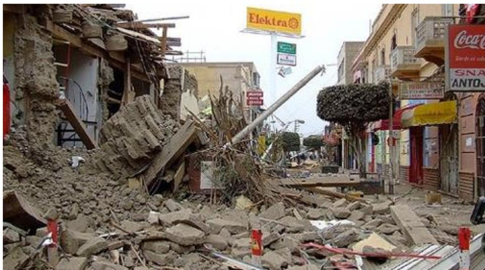
Fig. 1.14 Colapso de viviendas de adobe durante el sismo de agosto 2007 en Pisco mientras las edificaciones con otro sistema constructivo no colapsaron. [www.radiouno.pe/imagenes](http://www.radiouno.pe/imagenes).
