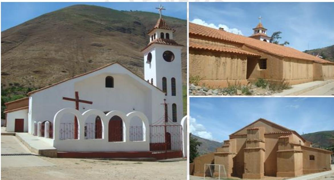
Fig. 1.8 Iglesia Mayor de Churubamba, de adobe enlucido con barro y pintado. Izquierda: vista frontal. Superior derecha: vista lateral. Inferior derecha: vista posterior.
