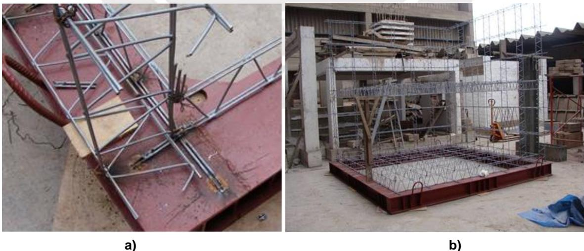
Fig. 3.6 a) Anclaje y soldadura al anillo de cimentación. b) Ensamblaje tridimensional formando parrillas y muros, a tramos equidistantes de 0,45 m (Departamento de Ingeniería Civil PUCP).
