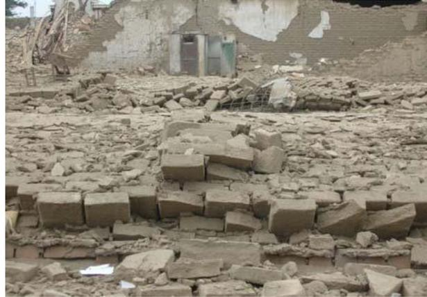
**Fig. 1.10 Colapso de vivienda con baja adherencia adobe-mortero. Sismo de Pisco, Perú 2007. (Misión CERESIS – UNESCO).**
