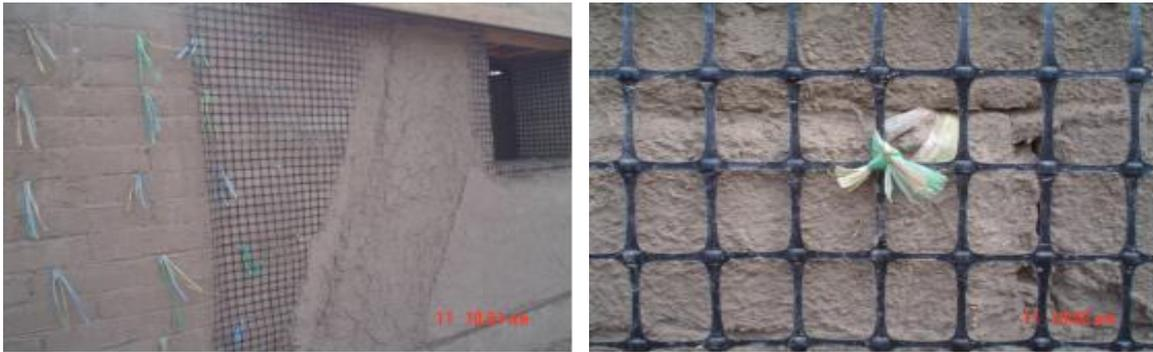
Fig. 1.17 Detalles de refuerzo con red polimérica en muros de adobe (Departamento de Ingeniería Civil PUCP).
