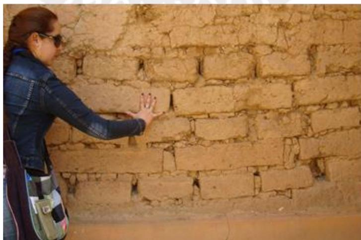
Fig. 1.9 Detalle muro lateral de la Iglesia Mayor, adobes con unidades e hiladas desiguales, juntas de diferente espesor sin llenar por completo. Churubamba, Huánuco.
