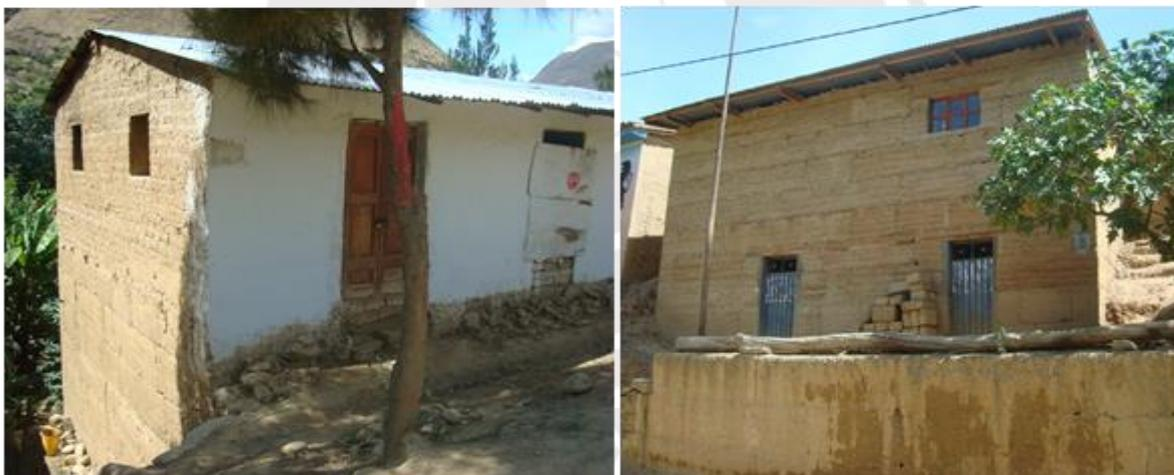
**Fig. 1.6 Viviendas de tierra de dos pisos. a) Adobe en segundo piso sobre tapial en primer piso. b) Construcción de tapial de dos pisos.**
