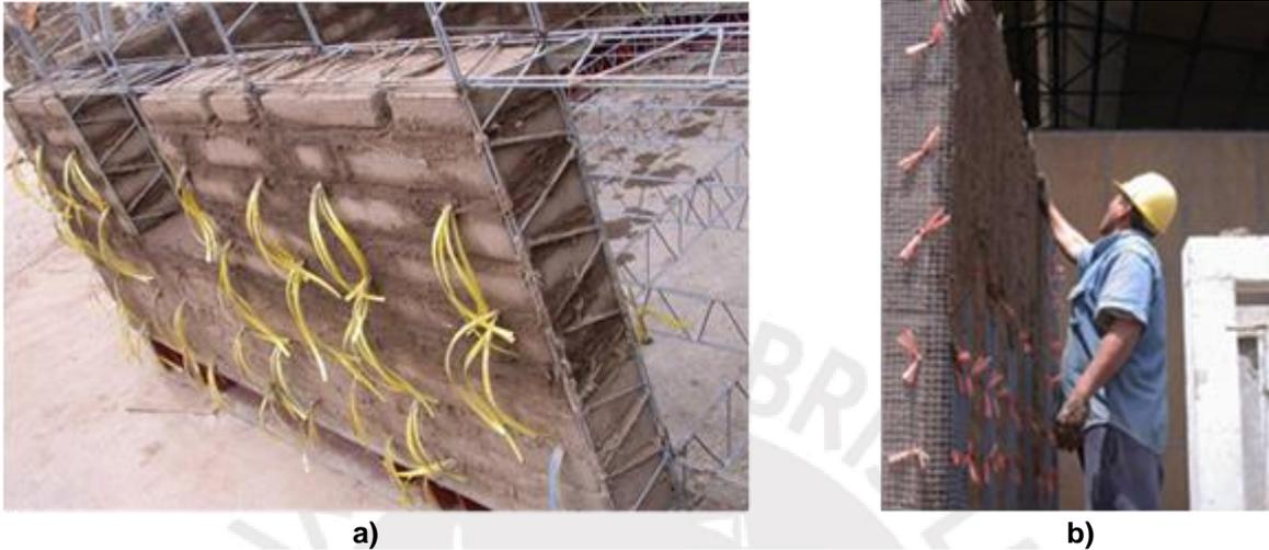
**Fig. 3.7 a) Asentado de adobes y pasadores de rafia para muro tarrajado. b) Colocación de malla polimérica y tarrajeo de muros (PUCP Departamento de Ingeniería Civil).**
