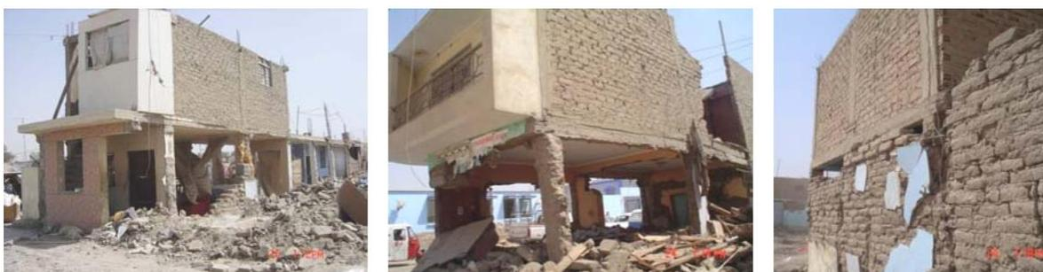
**Fig. 1.7 Colapso de primer piso de adobe, sobre el cual se construyó con albañilería. Pisco – Perú, sismo agosto de 2007. (Departamento de Ingeniería Civil. PUCP).**
