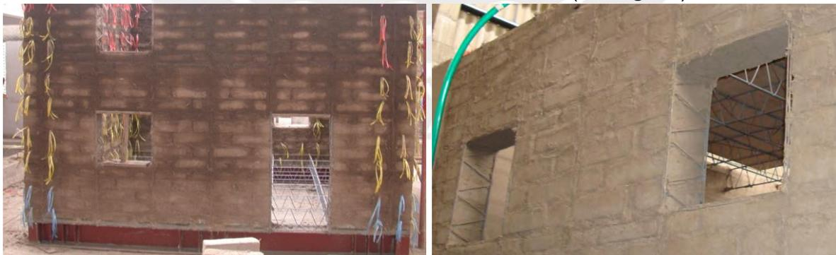
**Fig. 2.9 Vanos de puertas y ventanas durante la construcción y ya terminado el muro sin tarrajeo, se aprecian las cerchas como dinteles. (Departamento de Ingeniería Civil PUCP).**
