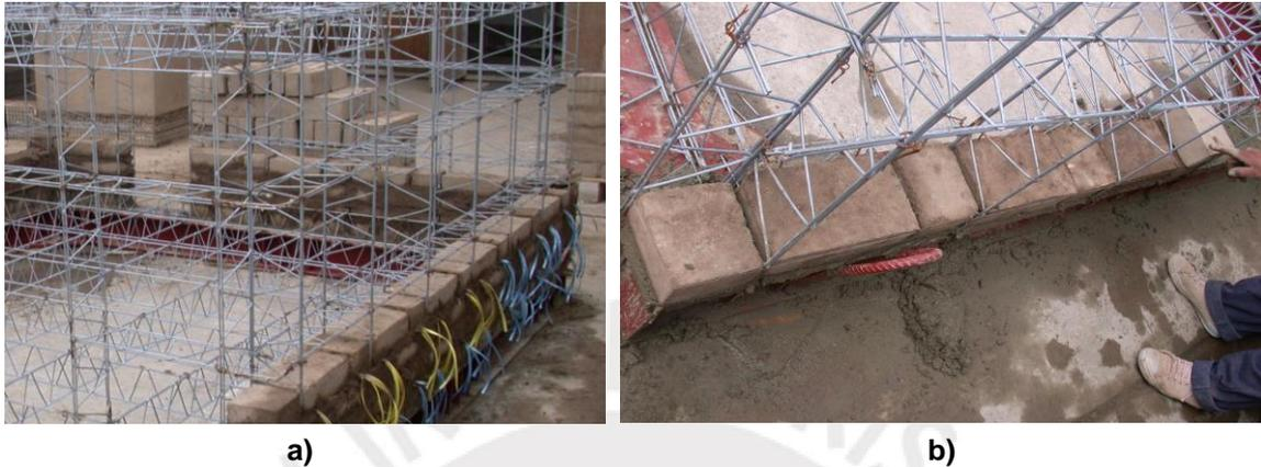
**Fig. 2.8 a) Detalle de unión entre cerchas verticales y horizontales en esquina. b) Modulado de adobes acorde a los vanos entre cerchas (Departamento Ing. Civil PUCP).**
