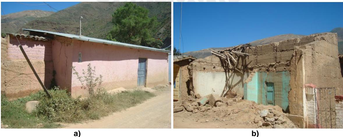
**Fig. 1.11 a) Separación de muros por falta de elementos de confinamiento. b) Caída de muro por volteo.**
