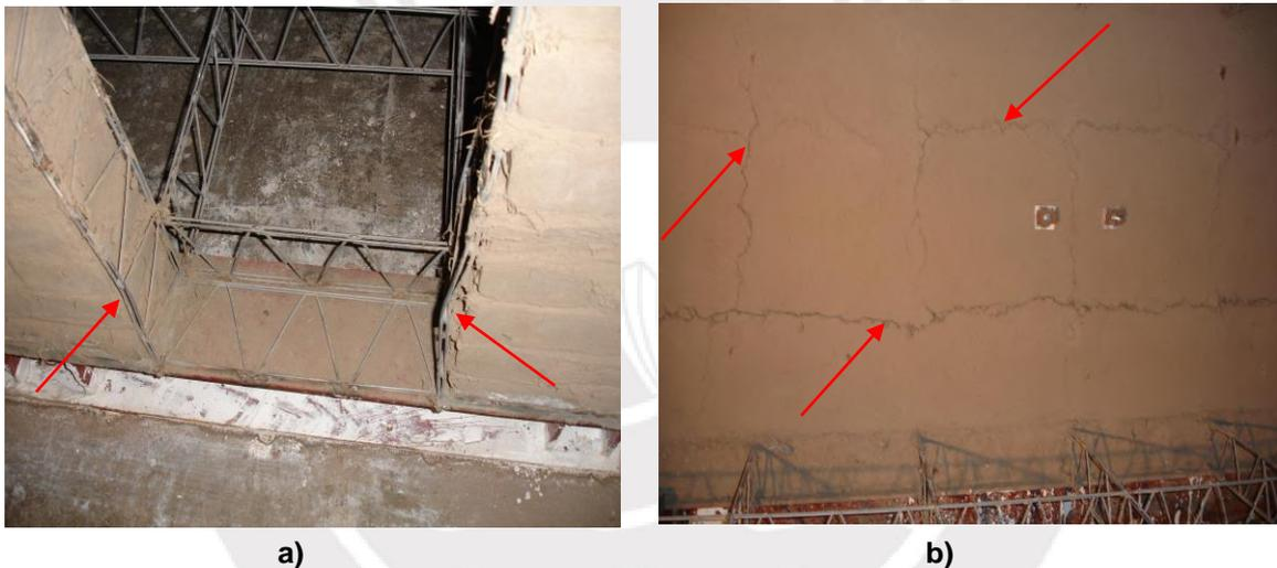
**Fig. 5.9 a) Muestra deformación en vano de puerta MP. b) MD muestra fisuras internas.**
