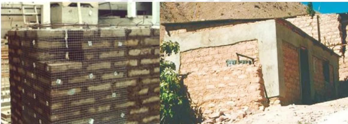
Fig. 1.18 a) Espacio para el diente de concreto en extremos de la viga solera. b) Vivienda reforzada con malla electrosoldada. (Departamento de Ingeniería PUCP).
