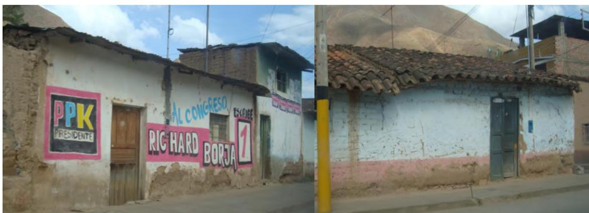
**Fig. 1.3 Viviendas de adobe con bases socavadas por las lluvias. Zona urbana de Huánuco.**
