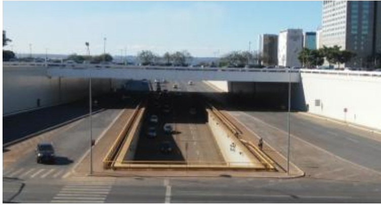
Figura 11. Brasilia: Plataforma Rodoviaria. Fotografía de los autores.
