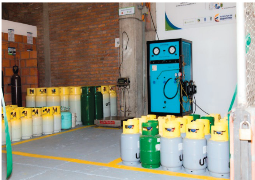
Figura 3. Maquina regeneradora Van Steenburgh JV 90 SC en el CRRR-EC.
