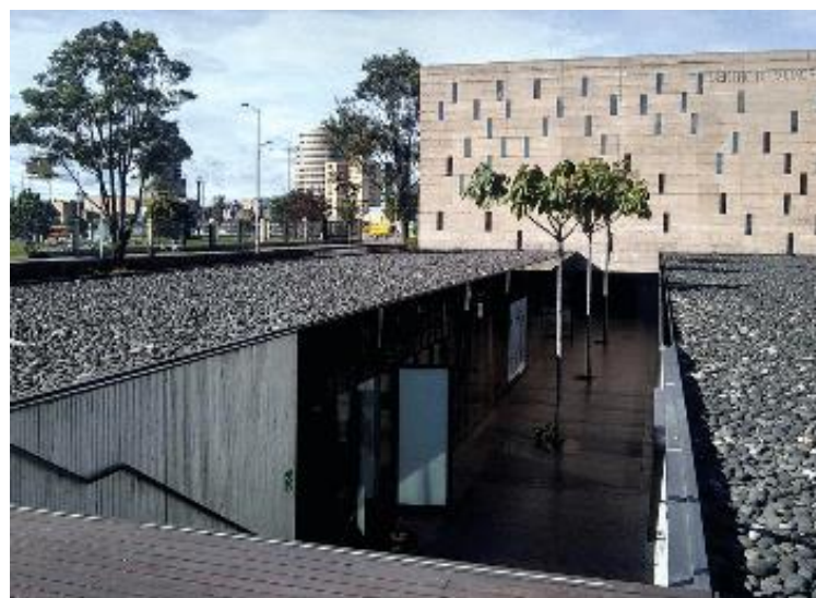
Fotografía 1 - Descenso al interior del monolito
