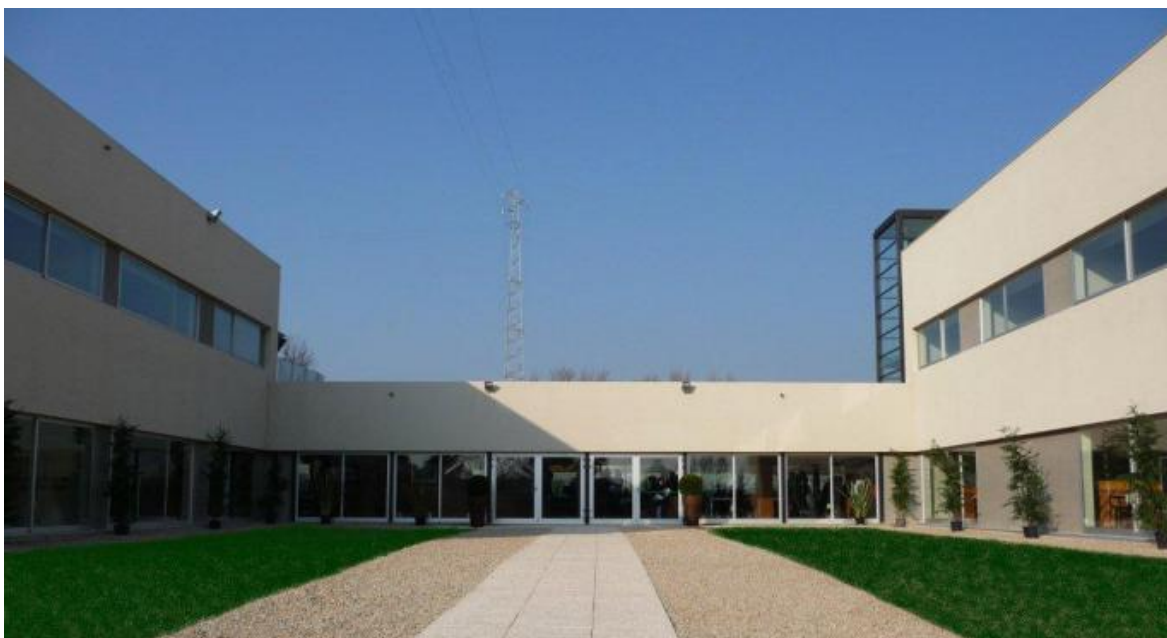
Figura 2: Fachadas do edifício da AMVP
