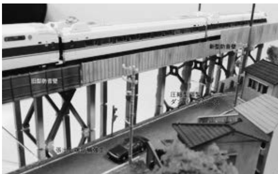
図5 耐震補強ならびに大規模改修による工事が施された高架橋の拡大図
