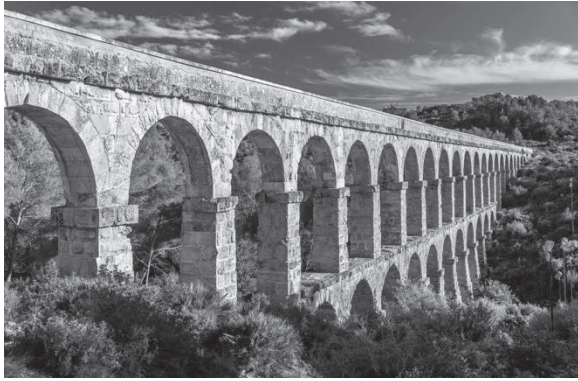
図6 それぞれのアーチがキャップストーンで完結し、アーチの連鎖で繋がれた石橋のイメージ ( https://www.kiwi.com/stories/6-devils-bridges-and-their-legends/ )
