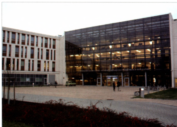
Fot. 41. Budynek Wydziału Zarządzania i Komunikacji Społecznej, Kampus 600-lecia Odnowienia Uniwersytetu Jagiellońskiego (fot. B. Piziak) Photo 41. The building of the Faculty of Management and Social Communication, Campus of the 600th Anniversary of the Jagiellonian University Revival (by B. Piziak)
