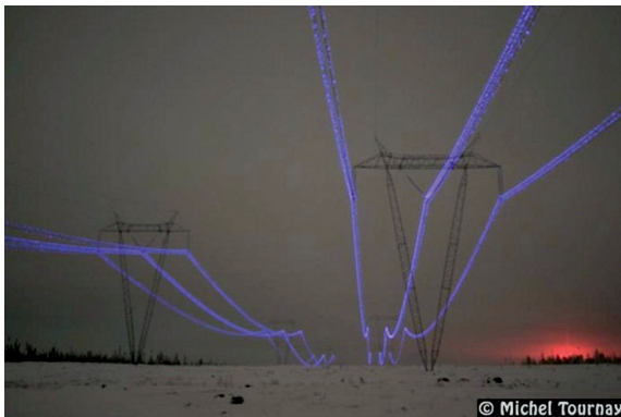
Rys. 5. Wyładowania koronowe wokół linii wysokiego napięcia
