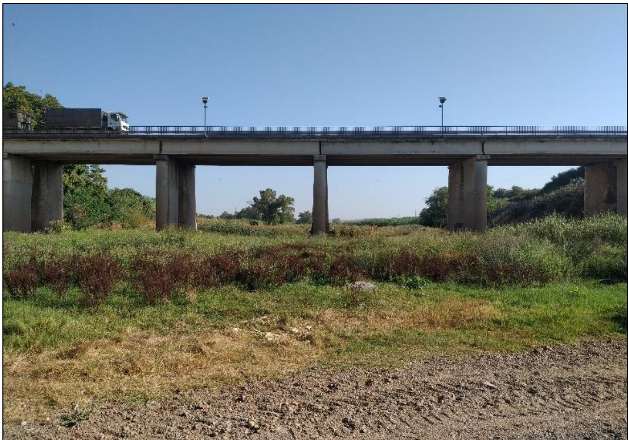
Figura 13. Puente sobre el río Viar.
