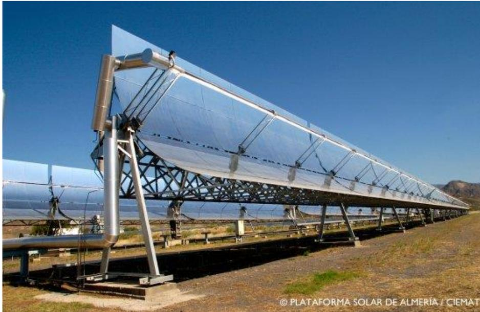
*Ilustración 11: Colector cilindroparabólico plataforma solar de Almería. [14]*
