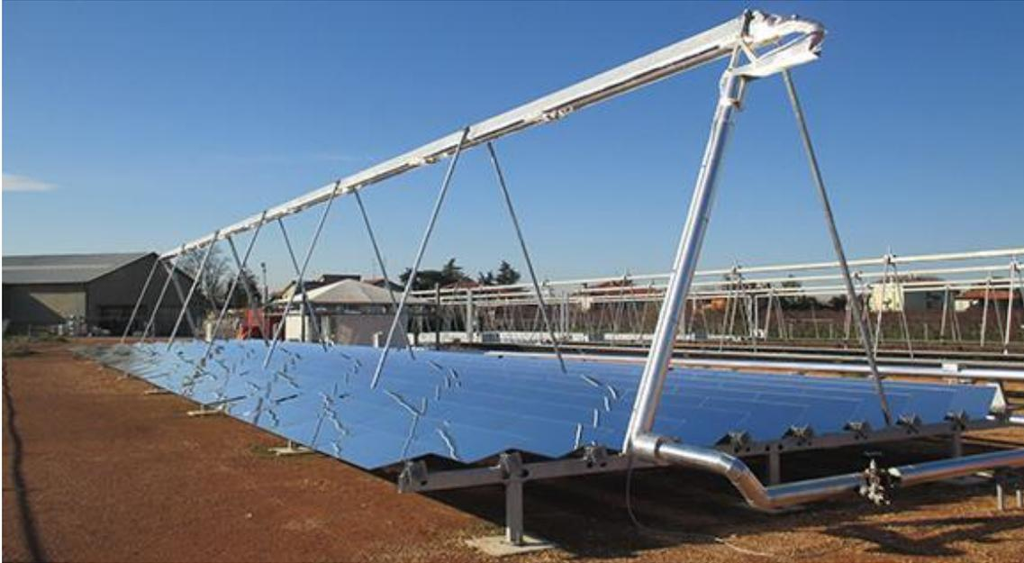
*Ilustración 10: Colector lineal Fresnel de Soltigua. [13]*
