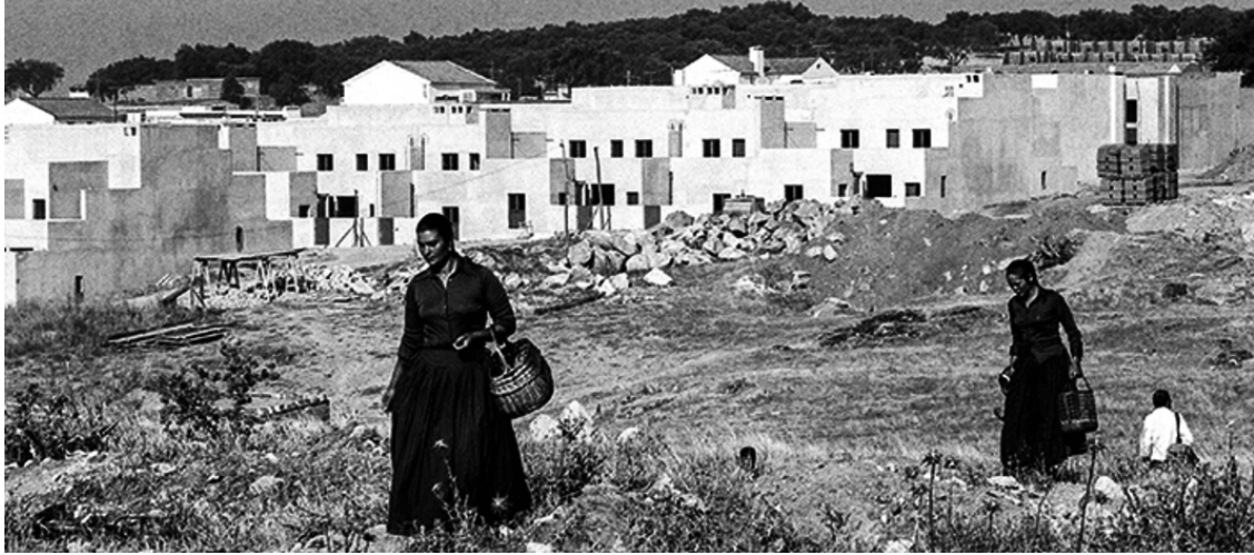
Fotografía 31. La Quinta da Malagueira durante su construcción . “Quinta da Malagueira” (Siza, A., 1977).
