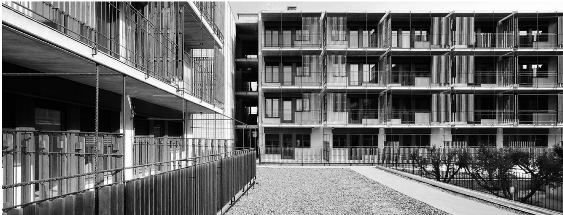
Fotografía 25. Edificio visto desde la calle. “80 Viviendas sociales en Salou” (Gironés, T., 2009).
