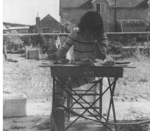
Fotografía 2. Alison Smithson durante en la obra. “Upper Lawn Pavilion” (Smithsons, 1959-1962).
