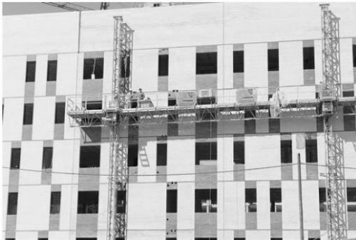
Varios operarios trabajan en la construcción de viviendas de alquiler. JUNTA
