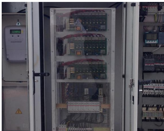
Ilustración 40. Regulador de tensión.
