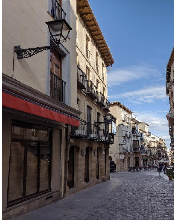
Ilustración 69. Faroles ornamentales con bloques ópticos instalados.
