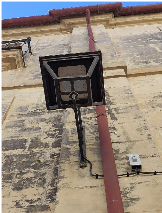
Ilustración 71. Detalle placa LED de bloque óptico en farol.
