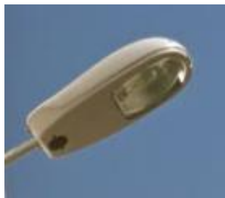
Ilustración 49. Luminaria Vapor de sodio.
