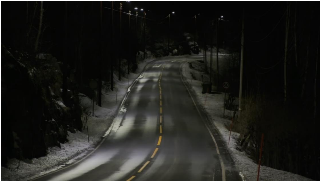
Ilustración 112. Vía con sensores de presencia en luminaria, inactivos.
