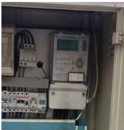
Ilustración 44. Autómata modelo Orbis Orbilux.
