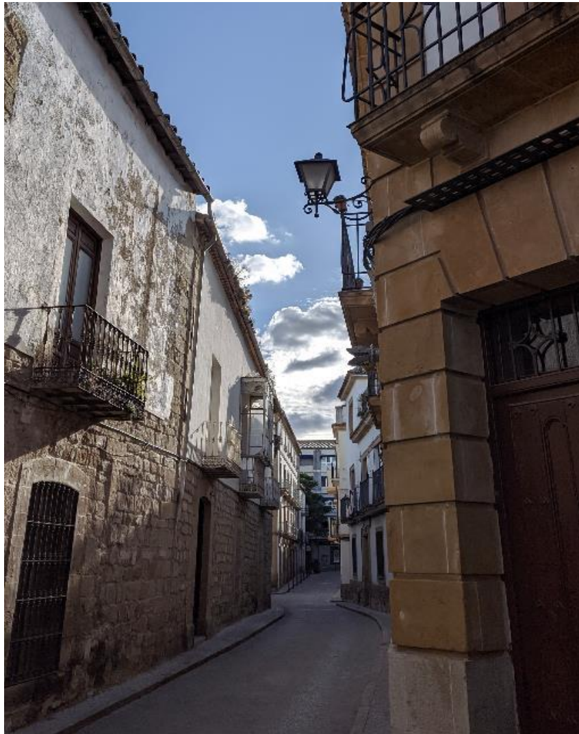
Ilustración 72. Farol ornamental sin instalación de bloque óptico.
