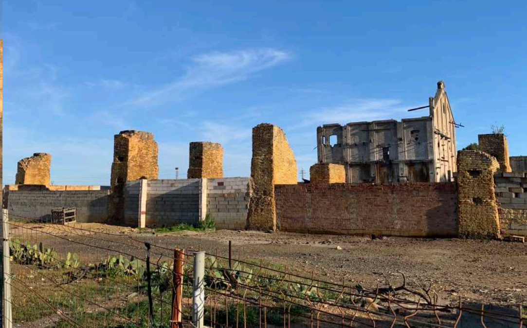
6 Depósito sur desde el pasaje de carga. Al fondo los restos de los antiguos talleres de máquinas
