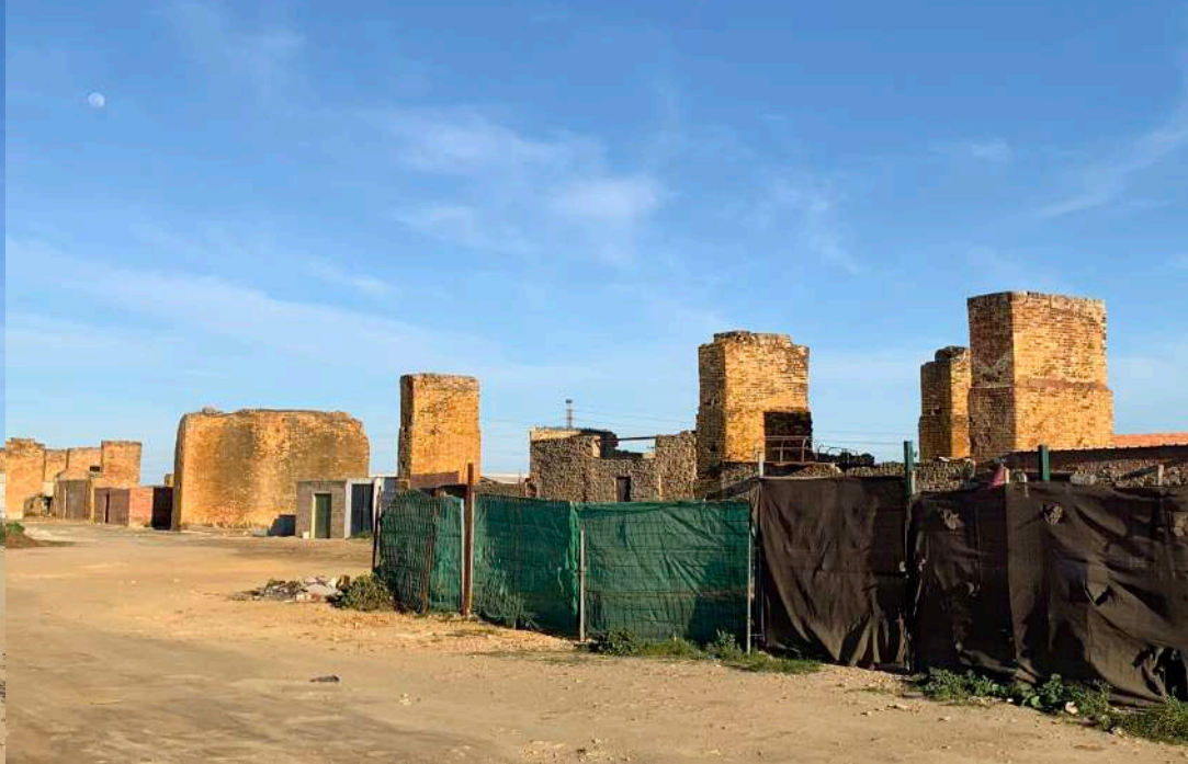
8 Depósitos norte (izquierda) y sur (derecha) fotografiados desde el antiguo pasaje de carga
