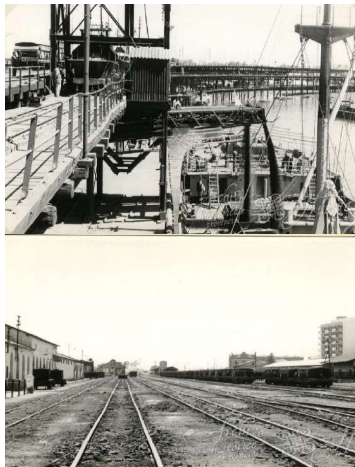
IMAGEN 11: Arriba: Muelle de Riotinto donde se pueden apreciar las tolvas empleadas para el embarque de mineral. F164-123. (Véase Anexo 11 y 12). Abajo: Apeaderos de espera para los vagones. F164-126.
