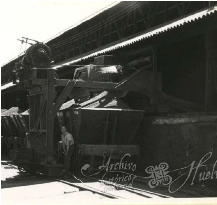
IMAGEN 12: Máquina con funcionamiento similar a las dragadoras de mina empleada para cargar los vagones con el material almacenado en los depósitos. Depósito sur. AHPH 164/138
