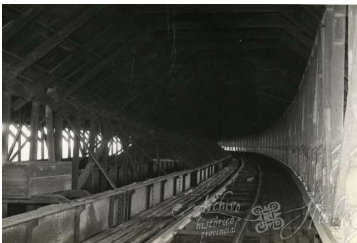
IMAGEN 17: Cota superior del depósito norte, vista interior. Estructura horizontal a base de vigas compuestas de alma llena. Archivo personal. Colección Riotinto. F-164/134
