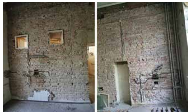
Slika 25. Karakteristični zidovi s otvorima i instalacijama
