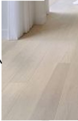
Piso de porcelanato tránsito medio o alto
