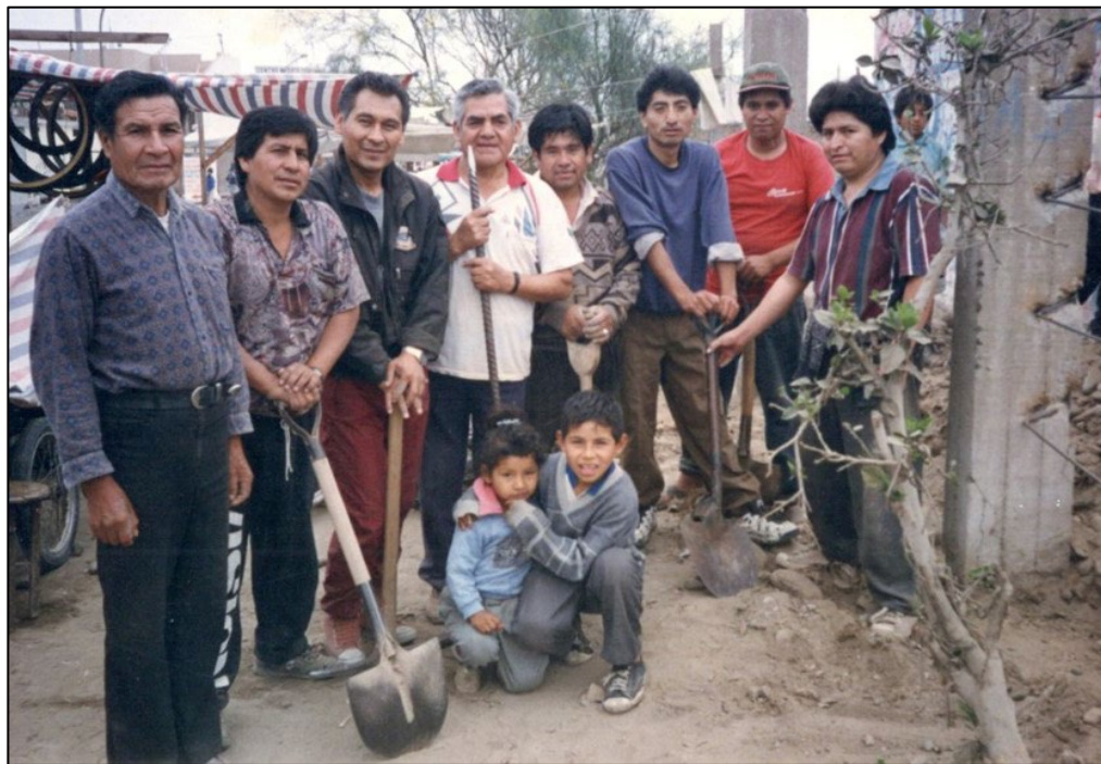
Figura 53. Pobladores construyendo el pórtico de entrada (2002)
