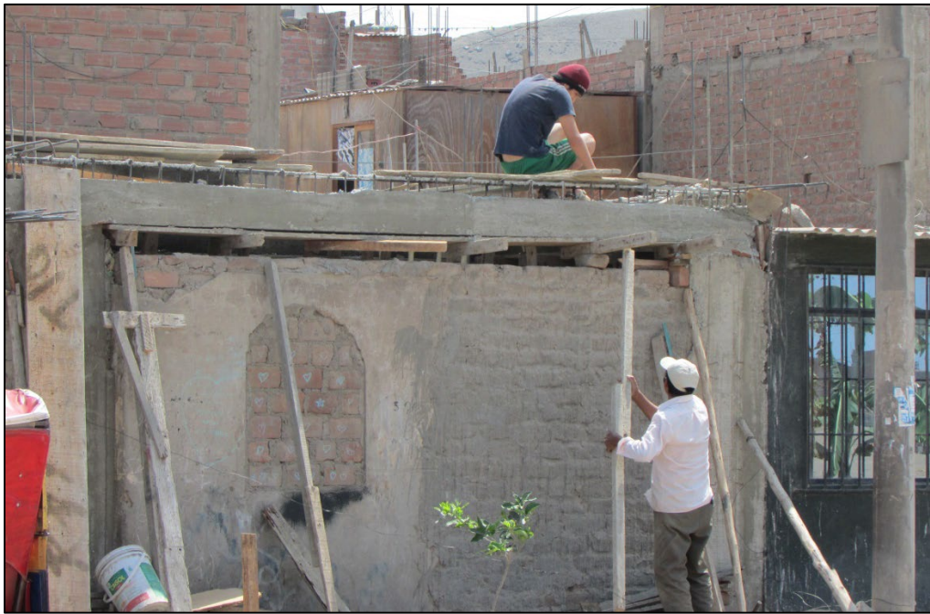
Figura 79. Pobladores realizando el techado en una vivienda (2018)
