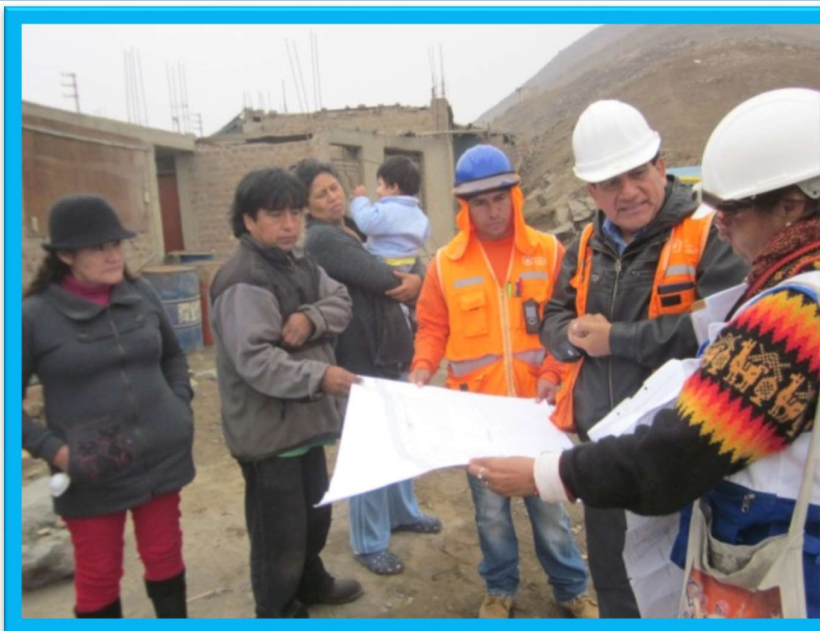
Foto N°18: Acompañamiento social en obra con el Ing. Gerardo Cabrera, encargo de frente en la habilitación Las Casuarinas, Cód. 35, paso de servidumbre – voladura por terreno rocoso para ejecutar la obra de agua y alcantarillado.
