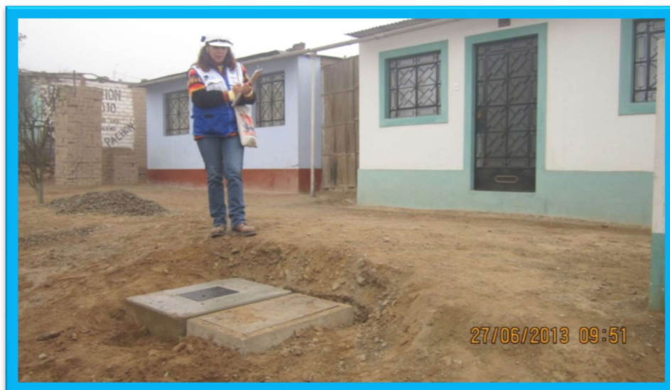
Foto N°28: Promotora social, Amalia Mena, realizando verificación de instalación de caja de agua y alcantarillado en el A.H. Asoc. Viv. Autog. San Benito VIII, Cód. 44.
