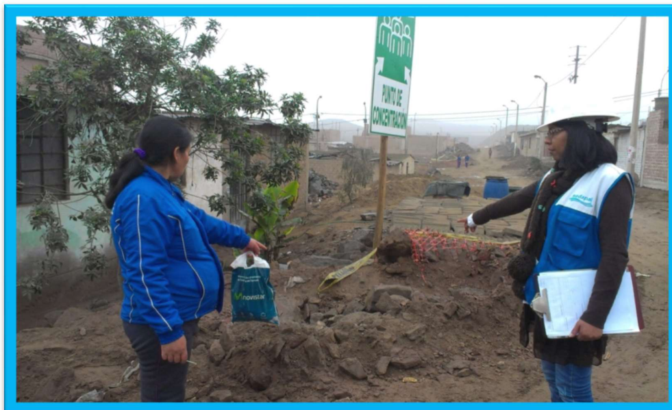
Foto N°26: Atendiendo la incidencia de la Mz. Q lote 9 de la habitación Nueva Jerusalén, Cód. 09, referente al desmonte y material dejado al frente de su lote.
