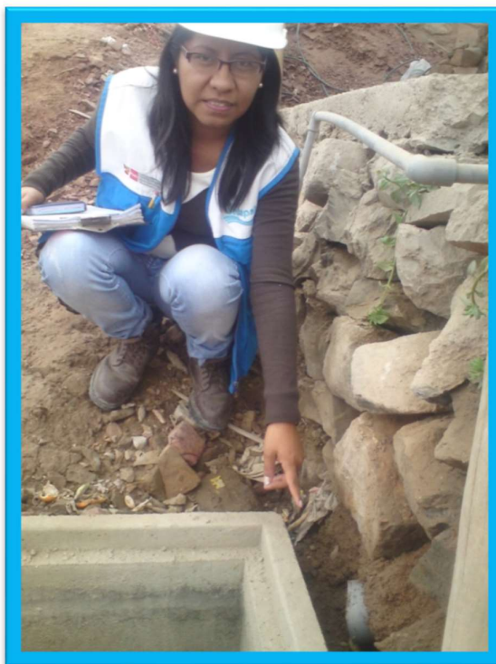
Foto N°29: Revisión de cajas de alcantarillados en la habilitación Comité vecinal Juan Pablo II, Cód. 14, como parte de la actividad de acompañamiento a obra.
